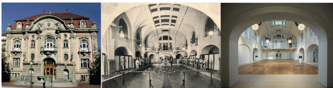
Vues de l'ancienne piscine : extérieur actuel, intérieur ancien et rénové
