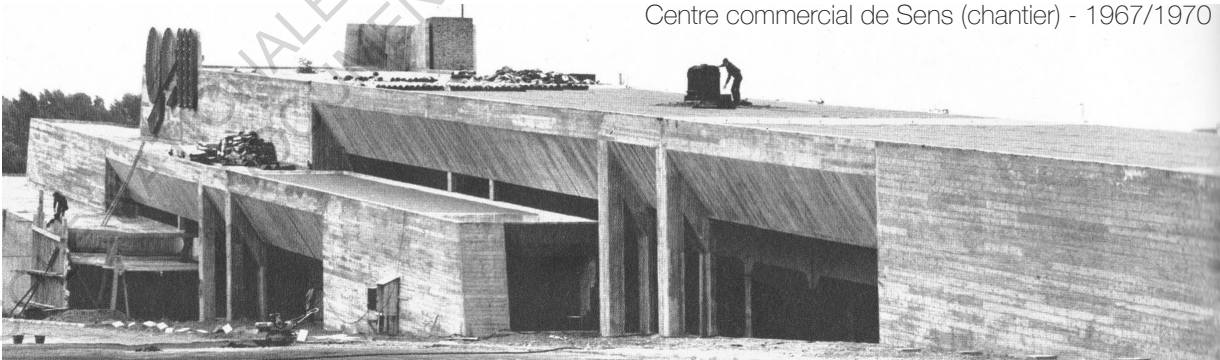
Centre commercial de Sens (chantier) - 1967/1970
