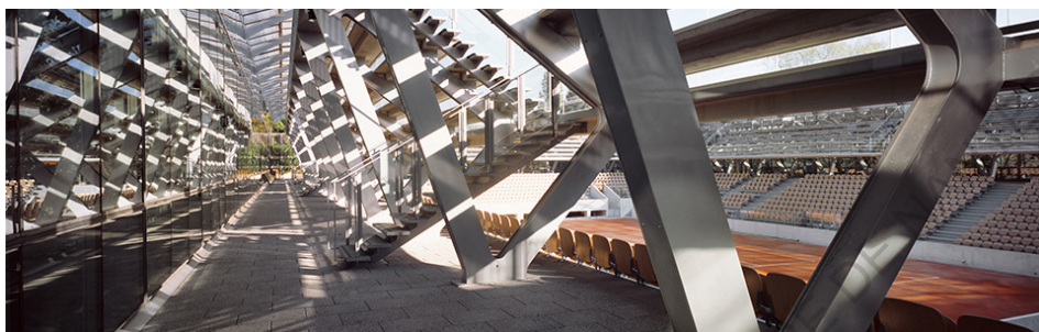
Ci-dessus : Vue intérieur du court Simone-Mathieu / Marc Mimram Architecture
