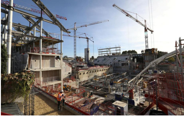
Ci-contre : Chantier du court Philippe-Chatrier le 23 octobre 2018 / LeParisien, Guillaume Georges
