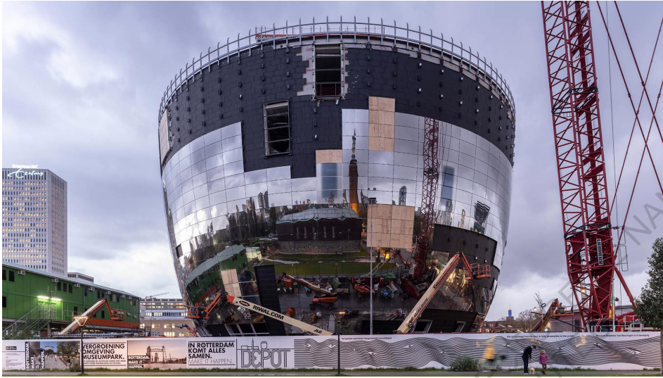
Ci-dessus : Photographie du chantier du dépôt / Rob Glasira
