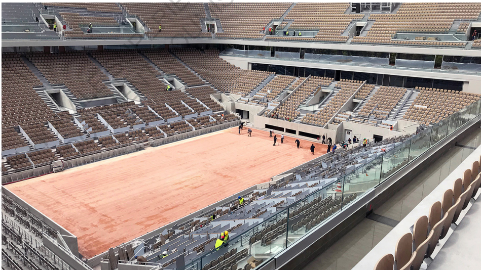
ci-dessus : Vu des gradins du court Philippe-Chatrier pratiquement terminé/ ACD Girardet & Associée
