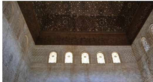
Figure 72 (en bas à droite, haut): Petites fenêtres hautes de la Salle des Rois.
