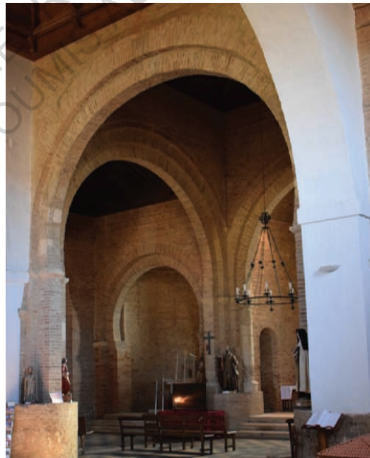
Figure 156 (en haut à gauche): Eglise San Tirso, Sahagun.
