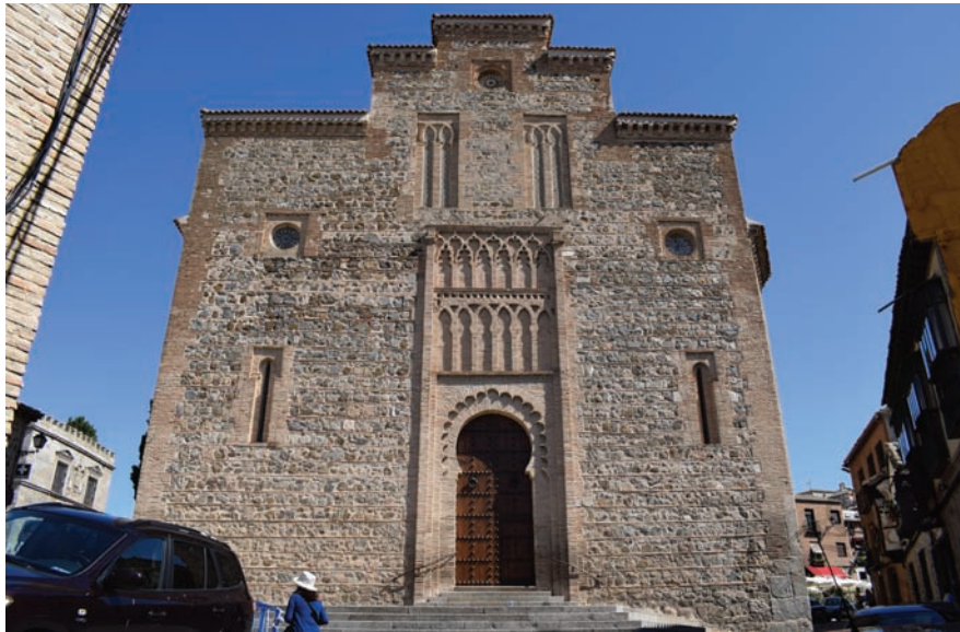
Figure 143: Façade principale, église Santiago del Arrabal, Tolède.
