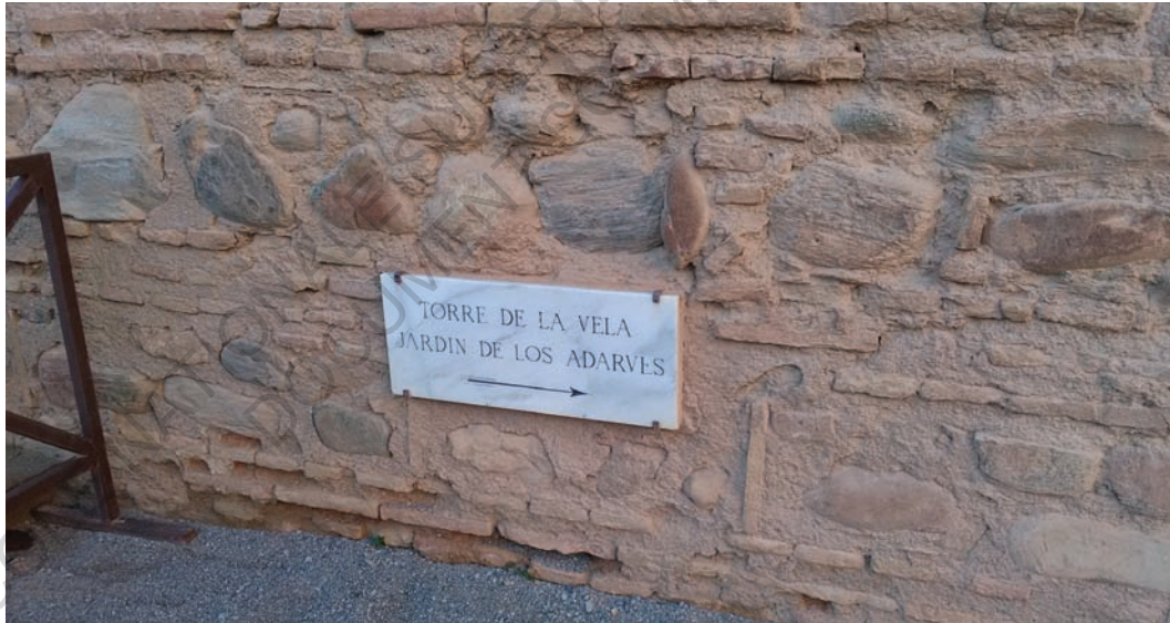
Figure 47 (en haut à gauche): Tours en pisé.
