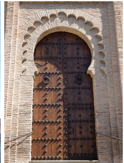
Figure 146: Porte en forme d'arc outrepassé inscrit dans un arc outrepassé polylobé, église Santiago del Arrabal, Tolède.
