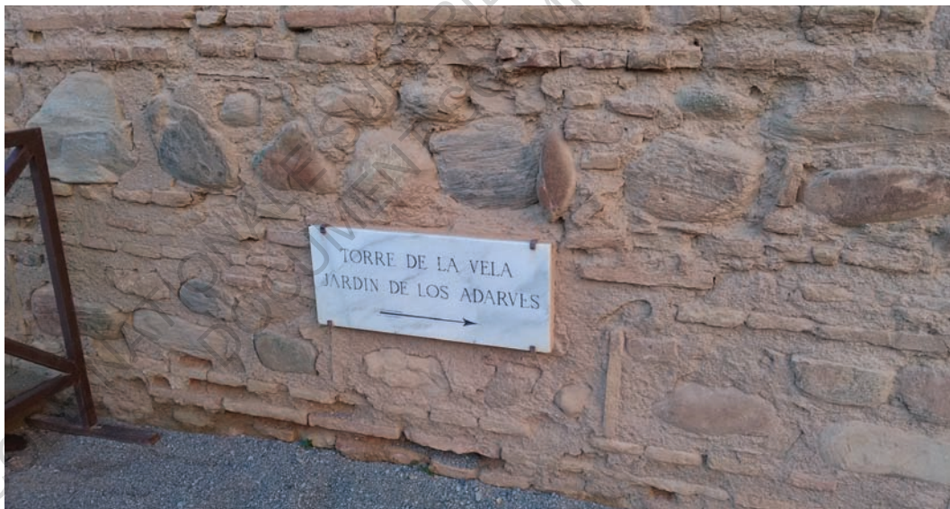
Figure 47 (en haut à gauche): Tours en pisé.
