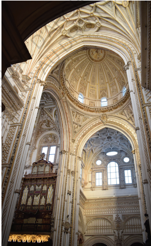
Figure 110: Coupole à nervure de la Chapelle Royale dans la Grande mosquée de Cordoue.
