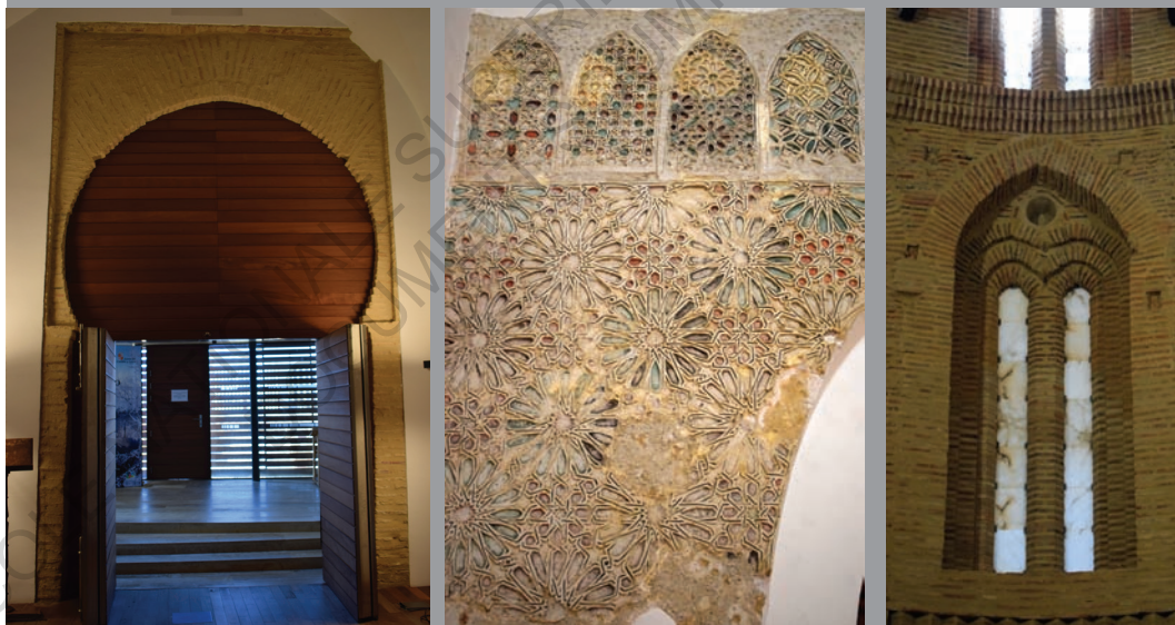
Figure 166 (en bas à gauche): Porte en forme d'arc outrepassé, La Peregrina, Sahagun.
