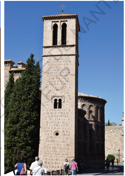
Figure 144: Tour en briques et moellons, église Santiago del Arrabal, Tolède.
