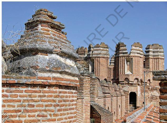
Figure 175: Muraille en brique avec ses merlons pyramidaux, château de Coca.
