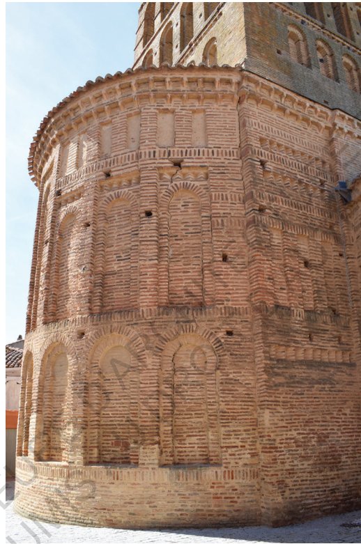
Figure 117 (en haut à gauche): Mur en moellons et briques, église Santiago del Arrabal, Tolède.
