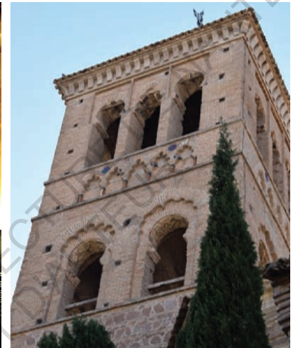
Figure 140: Tour en briques et moellons, église San Roman, Tolède.
