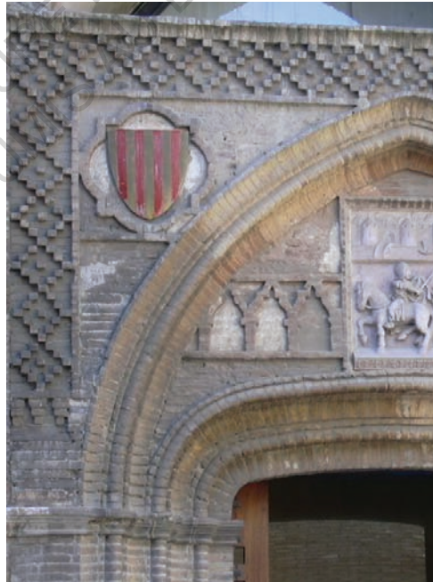
Figure 189 (en haut à gauche): Arcs polylobés, Aljaferia de Saragosse.
