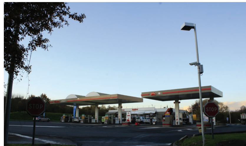
Aire de Services de la Grassinière aux portes de Nantes
