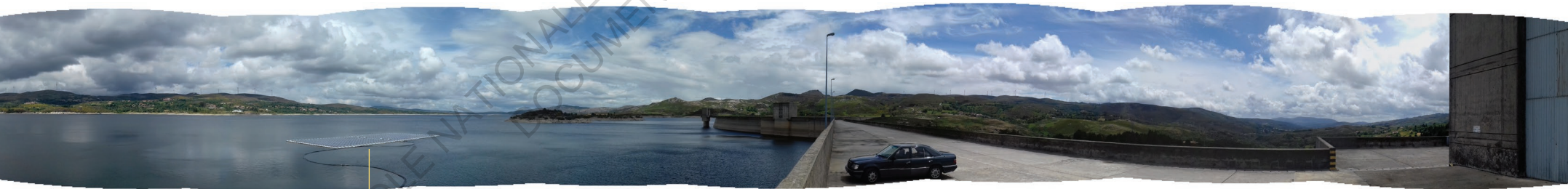
Barragem do Rabagão
