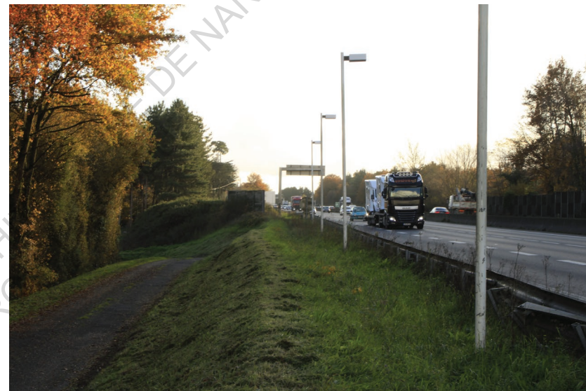
Voie d'accès des employés de l'Aire de Service de la Grassinière, le long de l'Autoroute des Estuaires (portion gérée par la DIR Ouest)
