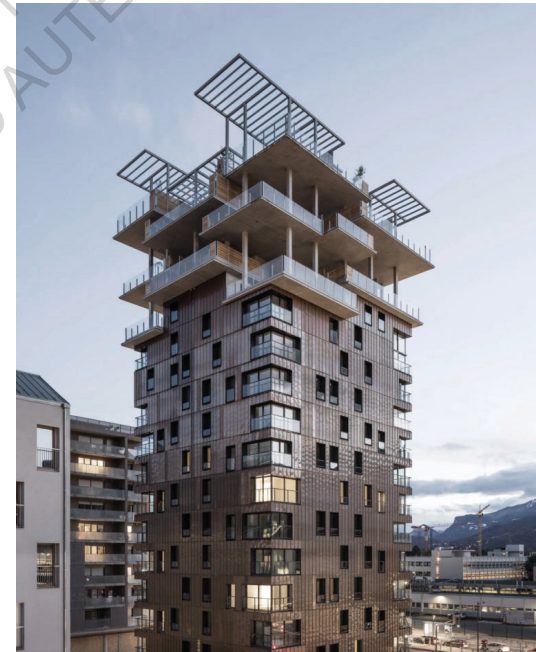
17, Edouard François, Immeuble Panache, Grenoble
