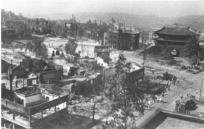
3, Démolition pendant la guerre de Corée, 1950
