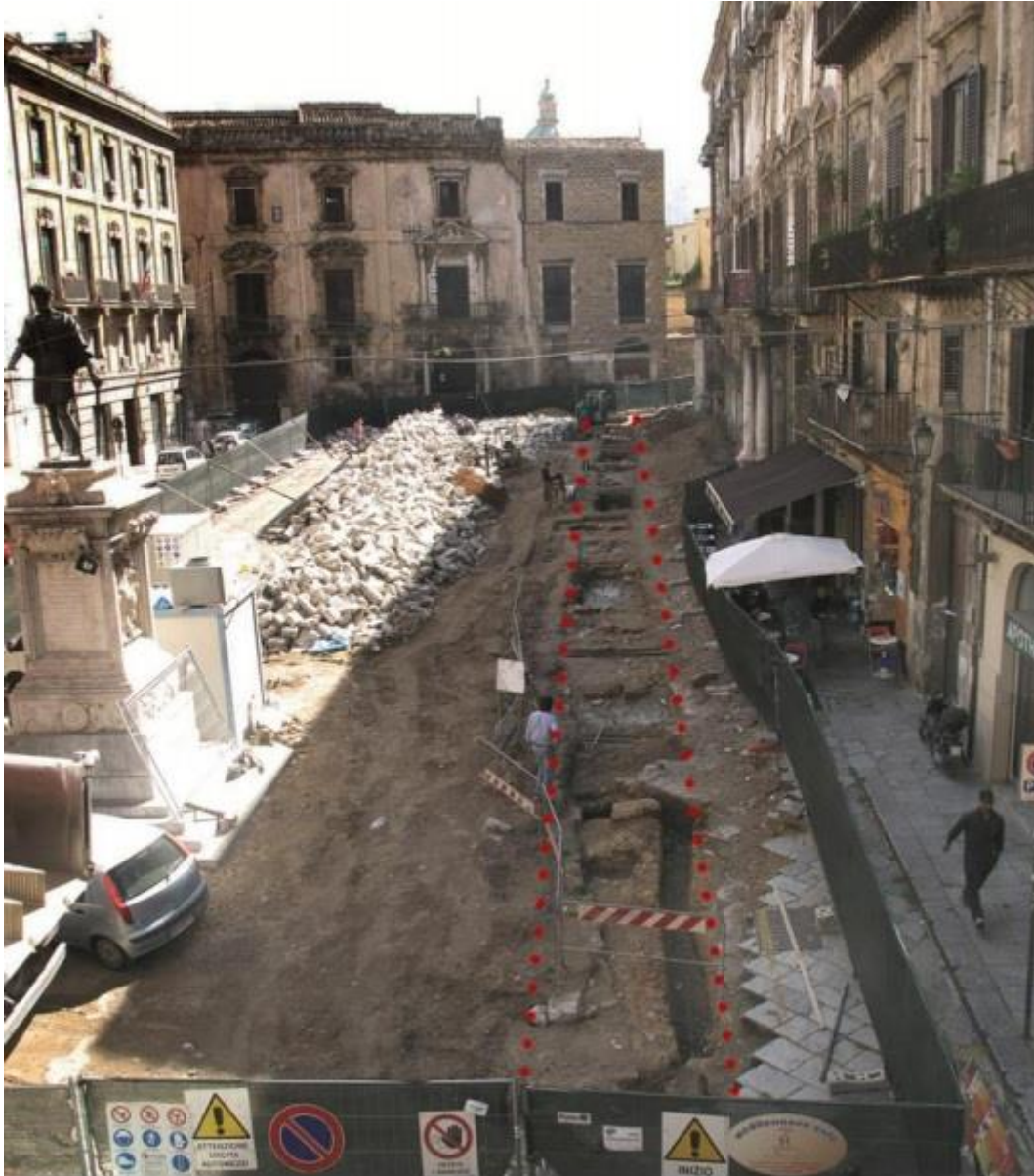
Annexe 3 : Tranchée des fouilles Piazza Bologni à Palerme en 2011
