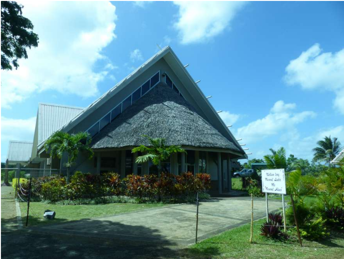
Figure 17 - Bibliothèque municipale, structure anticyclonique (Crédit photo : T.Vauthier, 2018)
