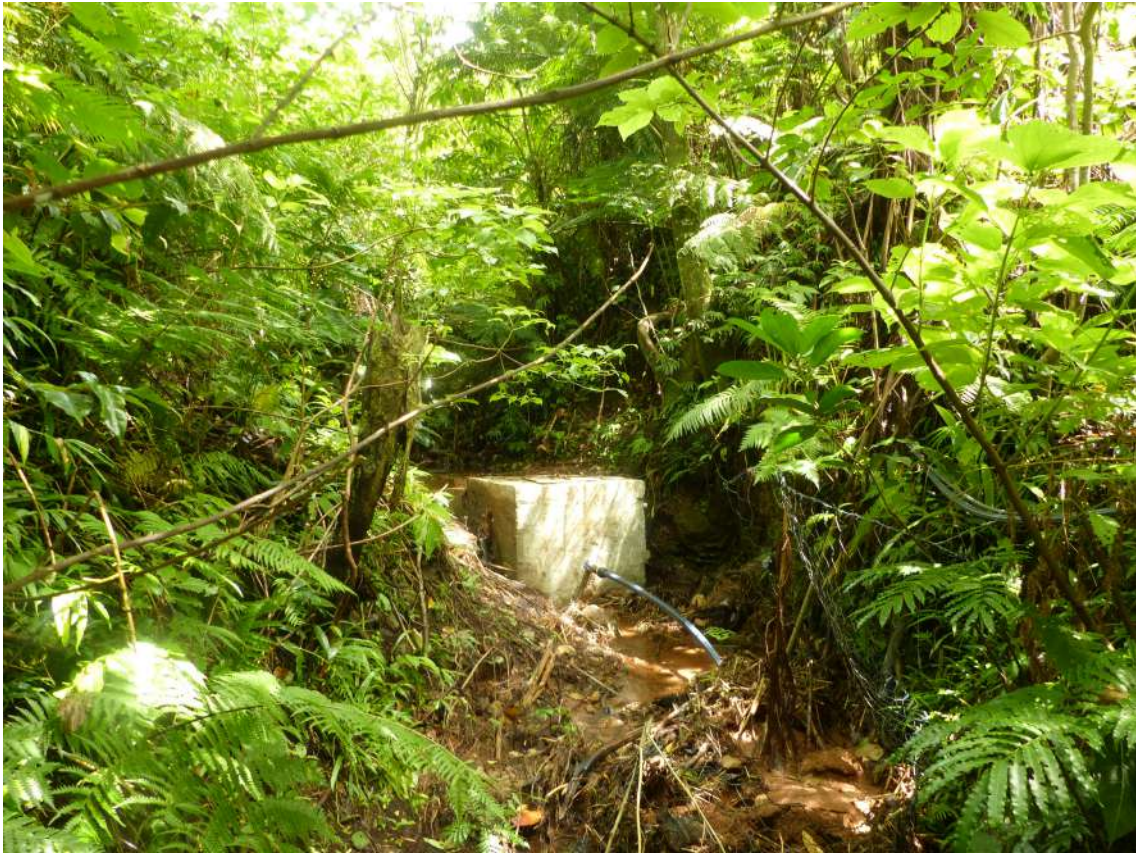
Figure 16 - Système hydraulique d'Imafen, impacté par une coulée de boue (Crédit photo : T.Vauthier)
