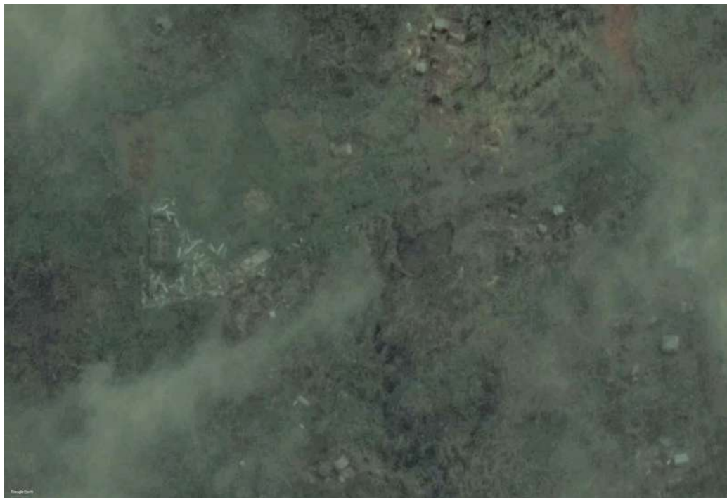
Figure 11 - École primaire d'Enhiu après le passage du cyclone Pam (Google Earth, 2015)
