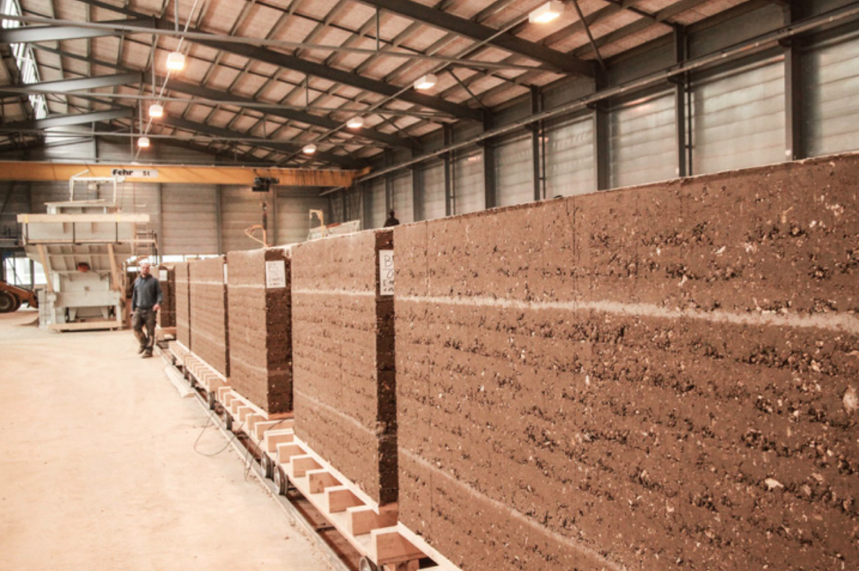
Figure 68 : Préfabrication Lehm Ton Erde / Photographie : © Daniel Lüthi
