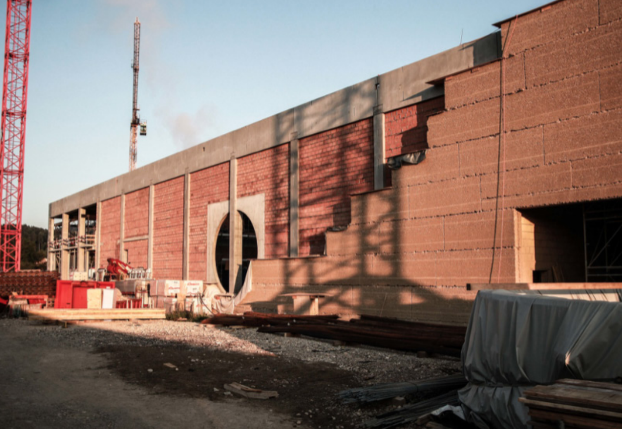
Figure 66 : Mise en place des blocs de pisé en façade / Photographie : © Daniel Lüthi
