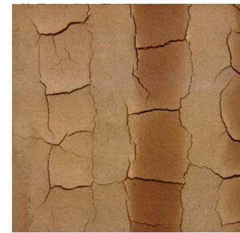
Figure 96 : Bandes verticales terre argilleuse fissurée
