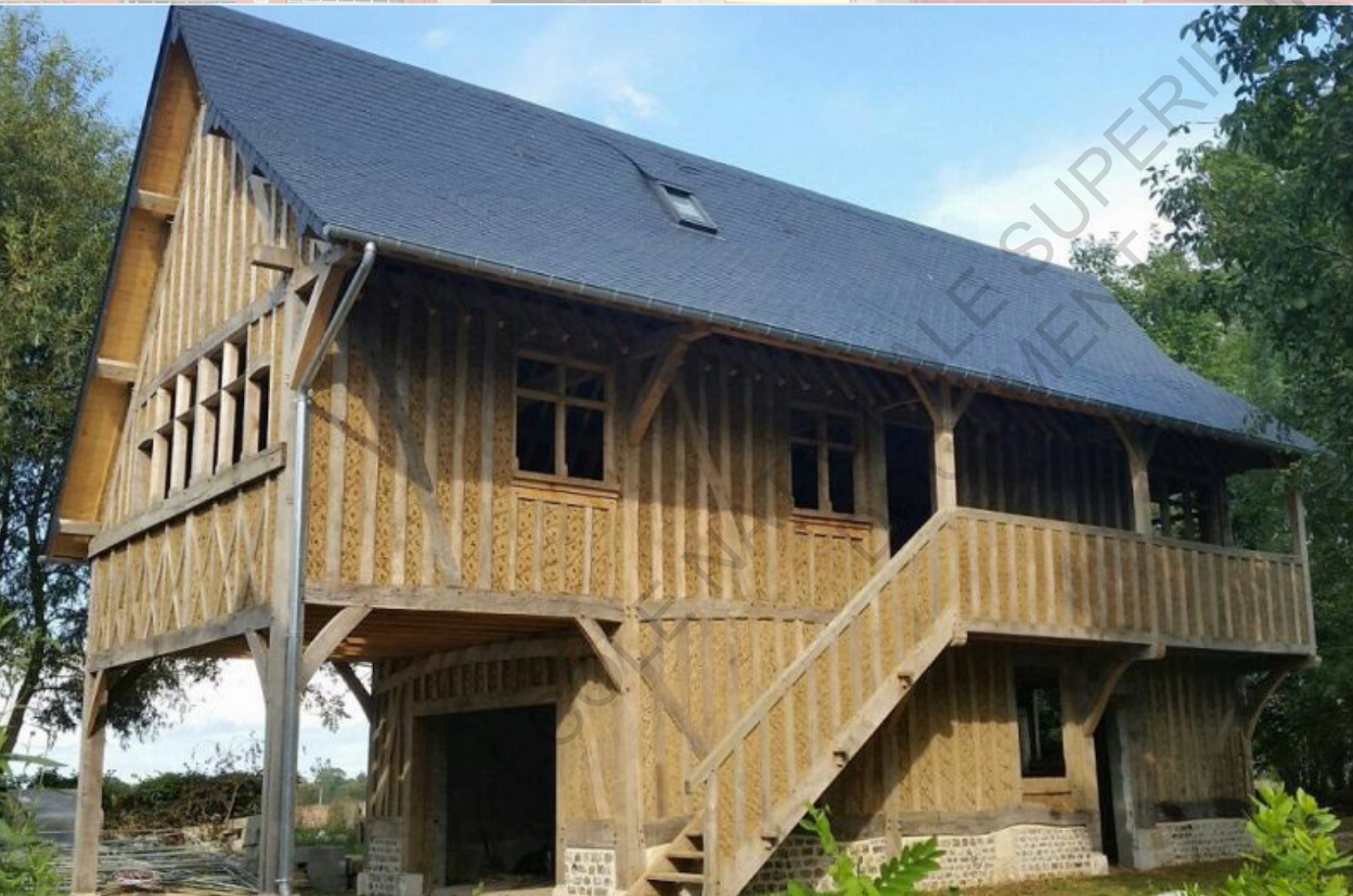
Figure 13 : Maison réalisée selon technique de colombages du XVe siècle , Normandie / Photographie : © Francis Plagnol
