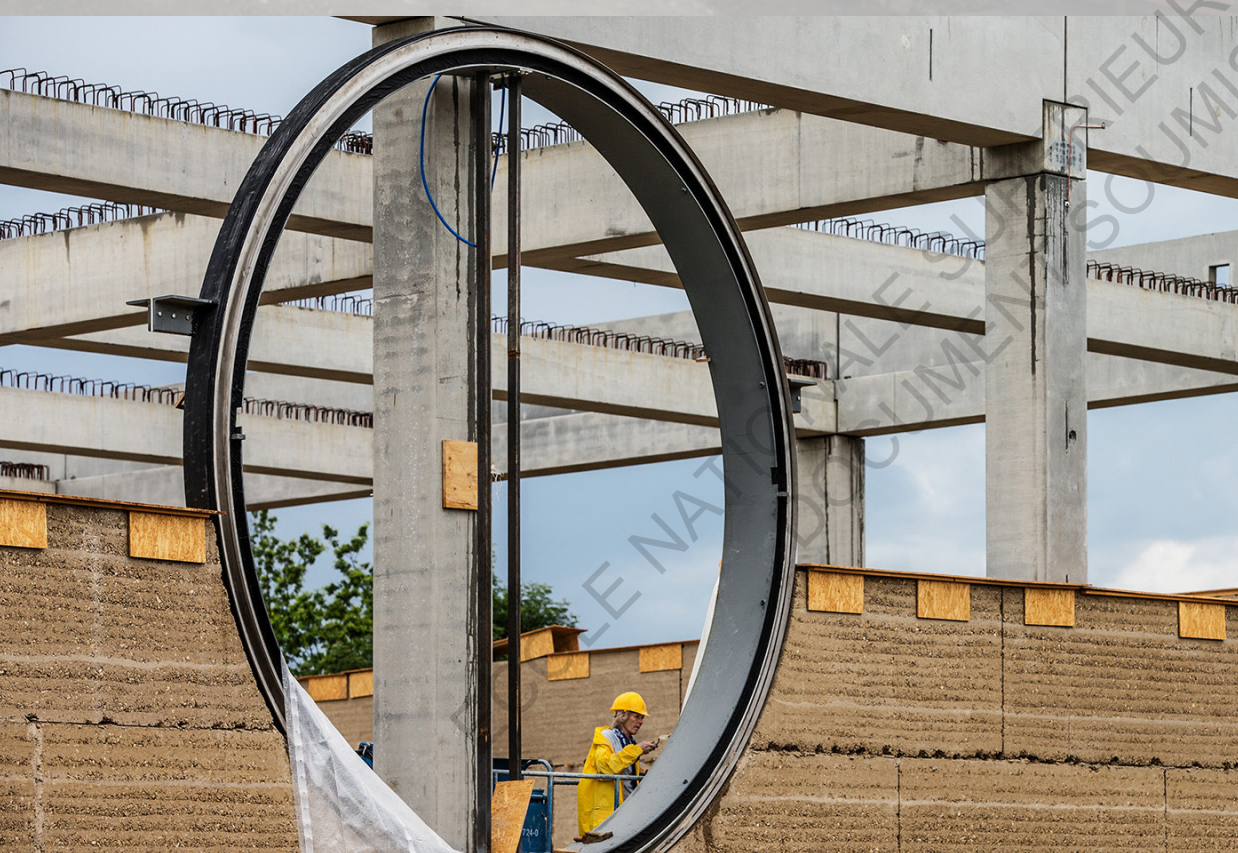
Figure 67 : Ouverture Ricola herb centre / Photographie : © Iwan Baan
