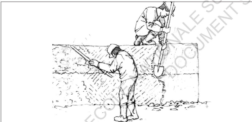
3) Redécoupage des murs avant séchage définitif
