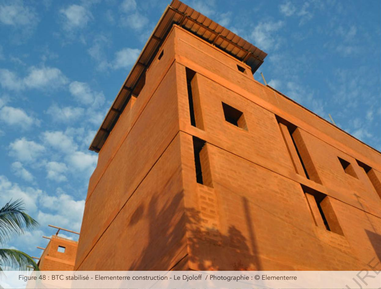
Figure 48 : BTC stabilisé - Elementerre construction - Le Djoloff / Photographie : © Elementerre
