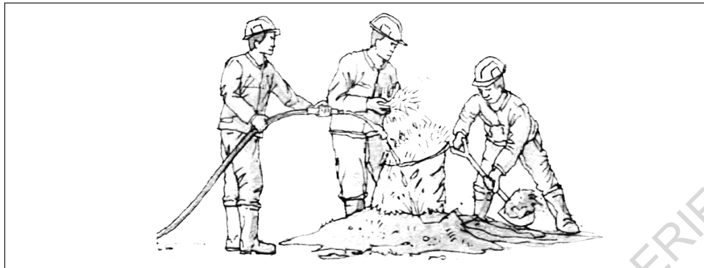
2) Réalisation du mélange terre-paille à l'état plastique
