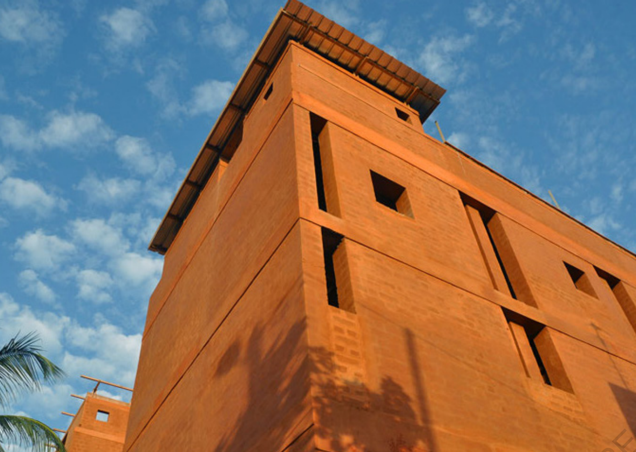
Figure 48 : BTC stabilisé - Elementerre construction - Le Djoloff / Photographie : © Elementerre
