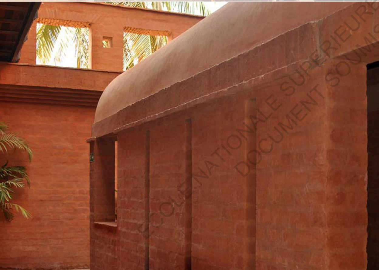
Figure 40 : BTC - Elementerre construction - Le Djoloff / Photographie : © ElementerreA
