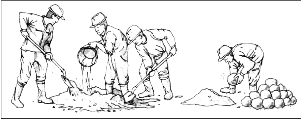
1) Mélange de la matière et préparation des mottes
