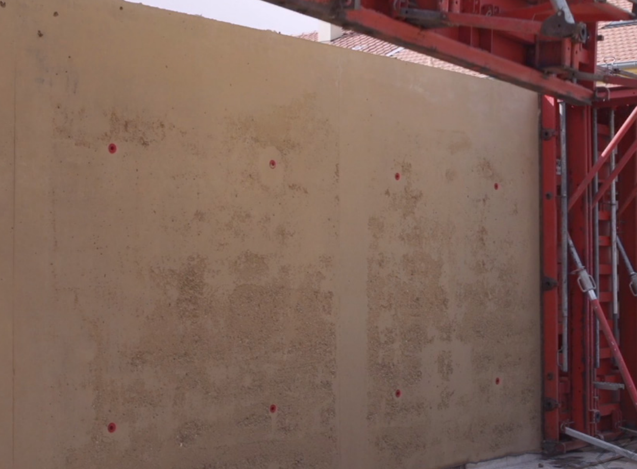
Figure 43 : Décoffrage terre coulée - Amo environnementale et certifications / Photographie : © flores-amo.fr
