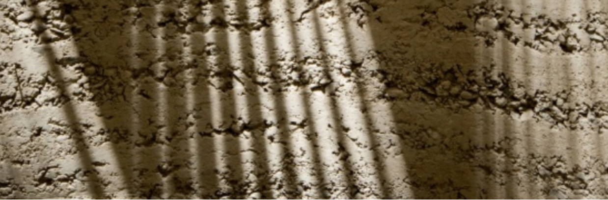
Figure 101 : Escalier maison de Martin Rauch / Photographie : © Beat Bühler
