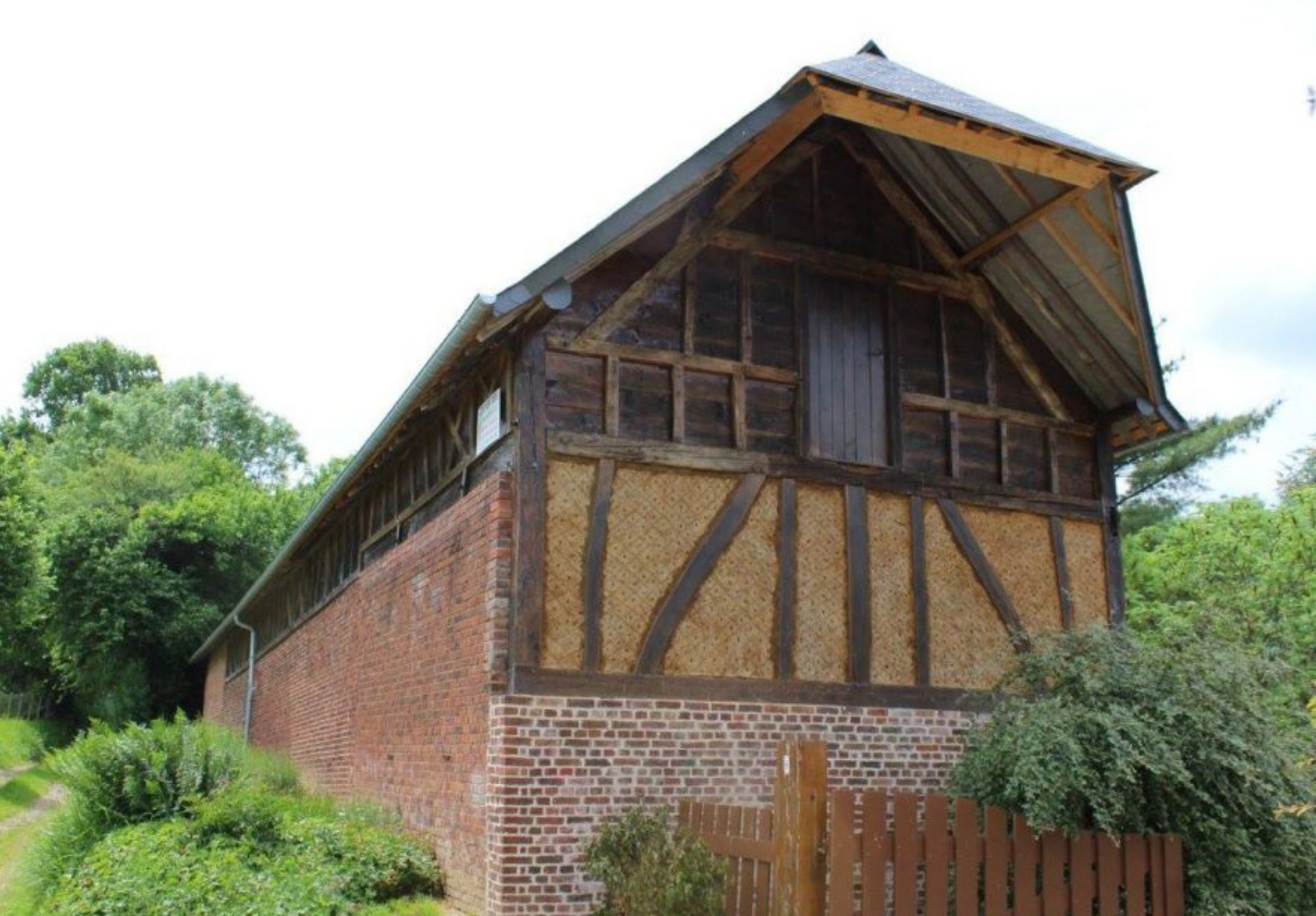
Figure 25 : Torchis sur lattes de châtaignier / Photographie : © Jan Minne
