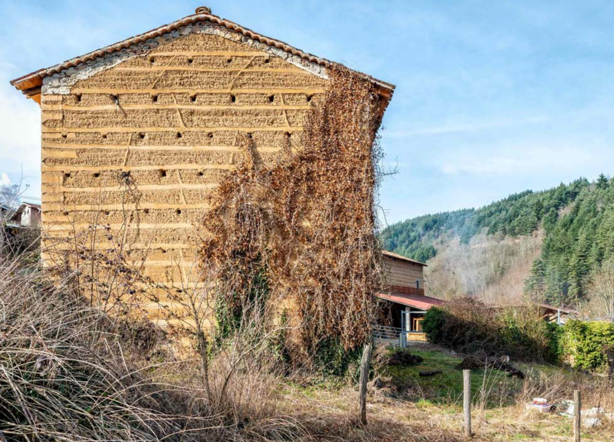
Figure 18 : Haute Savoie / Photographie : © Architektur photographie Philip
