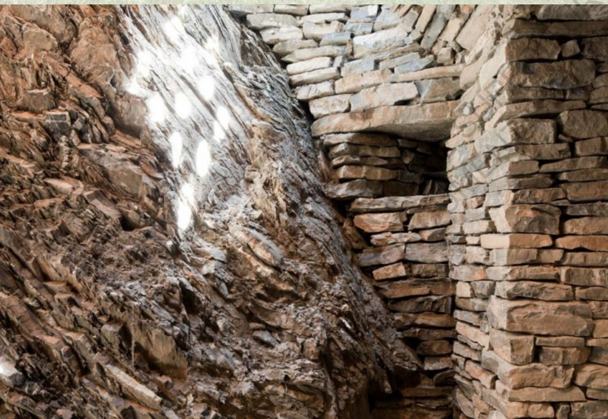
Figure 59 : Mur arrière rez-de-chaussée, maison de Martin Rauch / Photographie : © Beat Bühler
