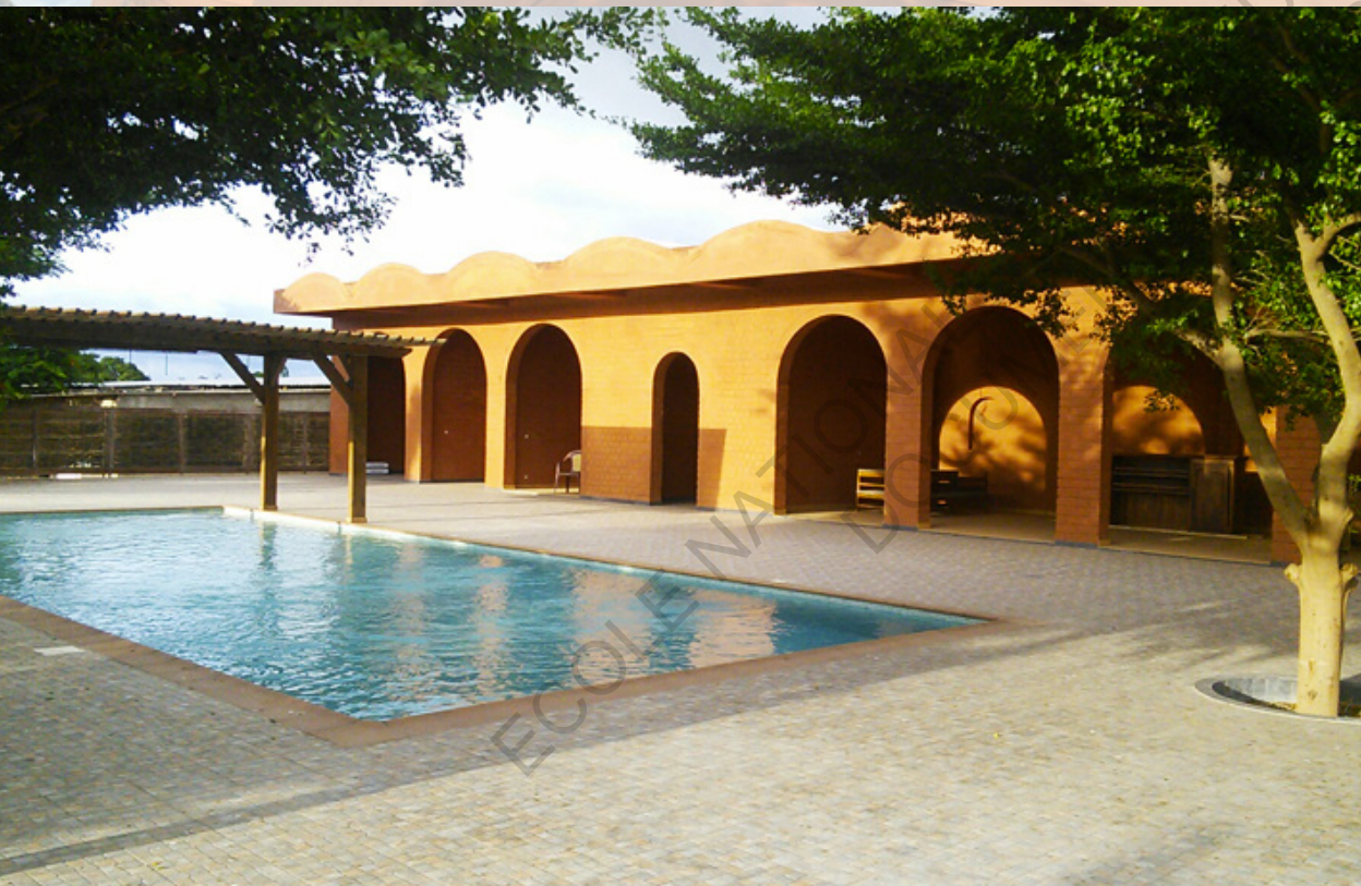
Figure 49 : BTC stabilisé - Elementerre construction - Le Bandia / Photographie : © Elementerre
