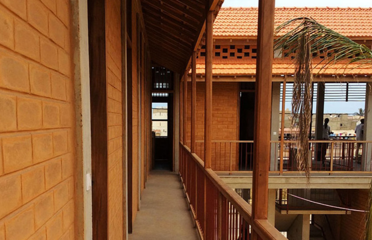
A Figure 38 : BTC - Elementerre construction - Le Djoloff / Photographie : © Elementerre
