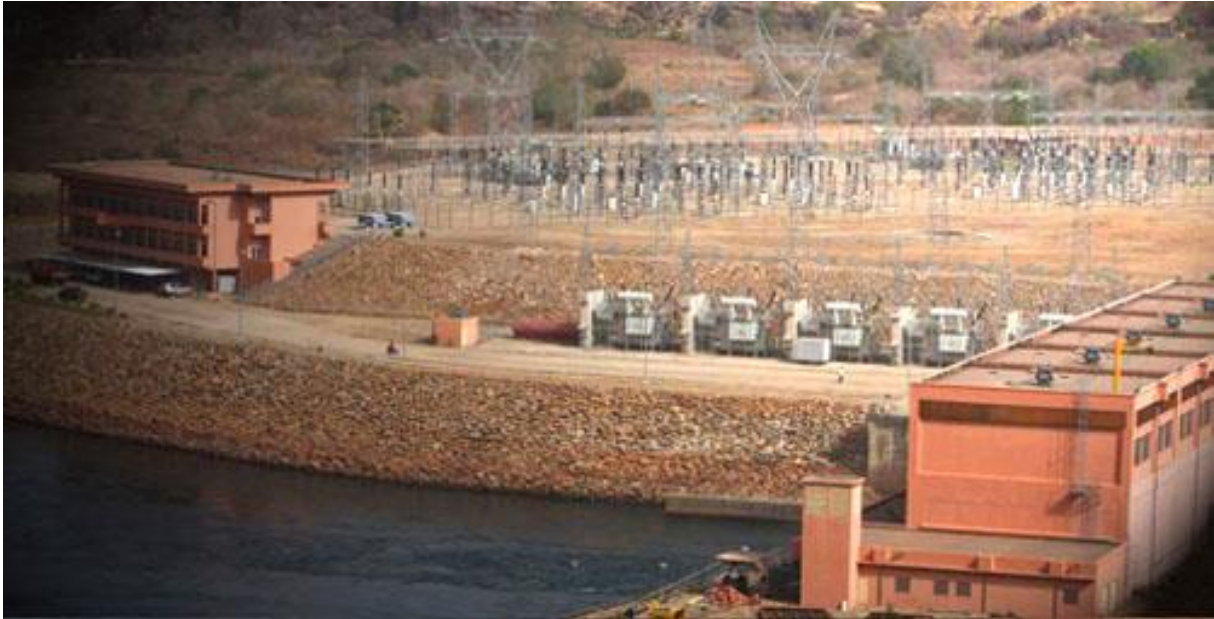
Figure 9 : Image de deux centrales électriques alimentées par le barrage de Manantali
