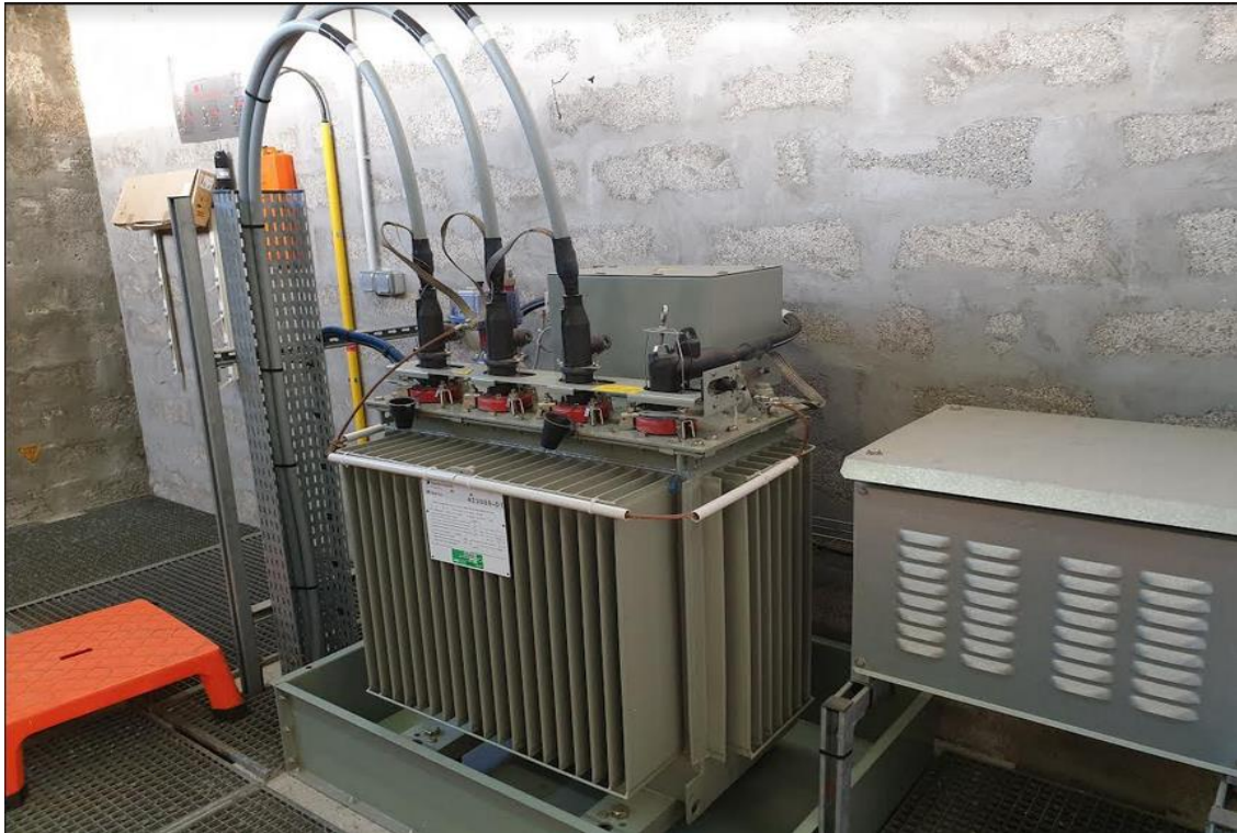
Figure II.8 : générateur homopolaire.
