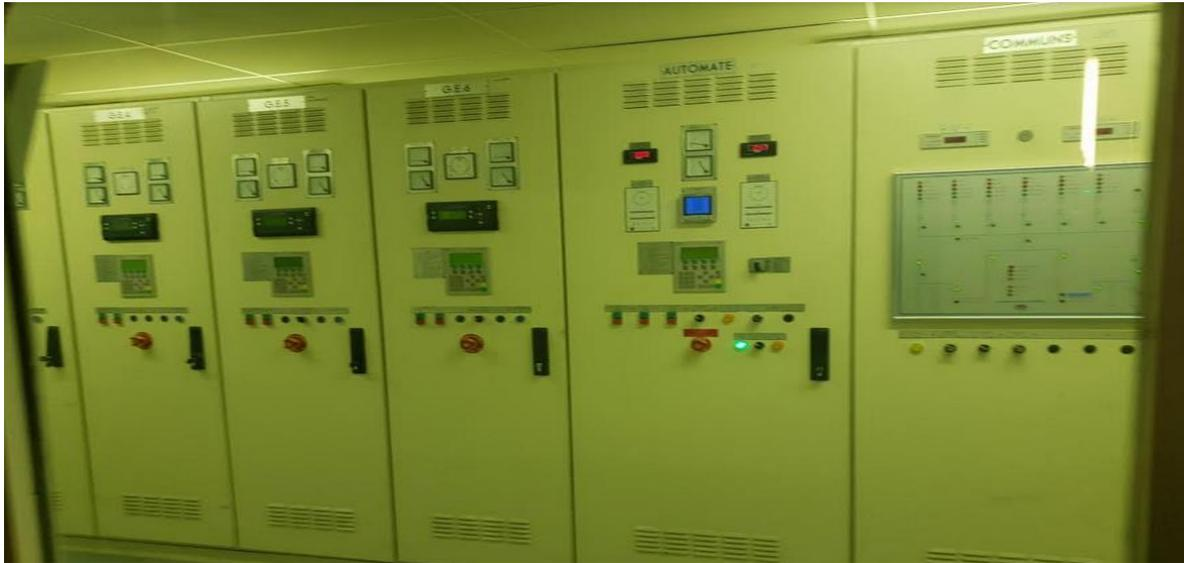
Figure II.4 : cellules de commande des GE.
