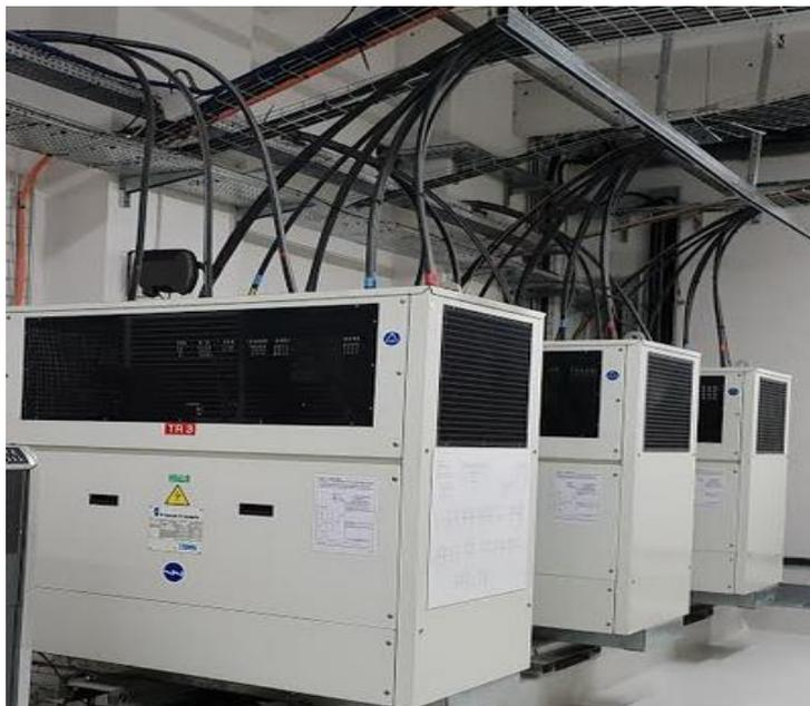
Figure III.2 : transformateur HTA/BT.
