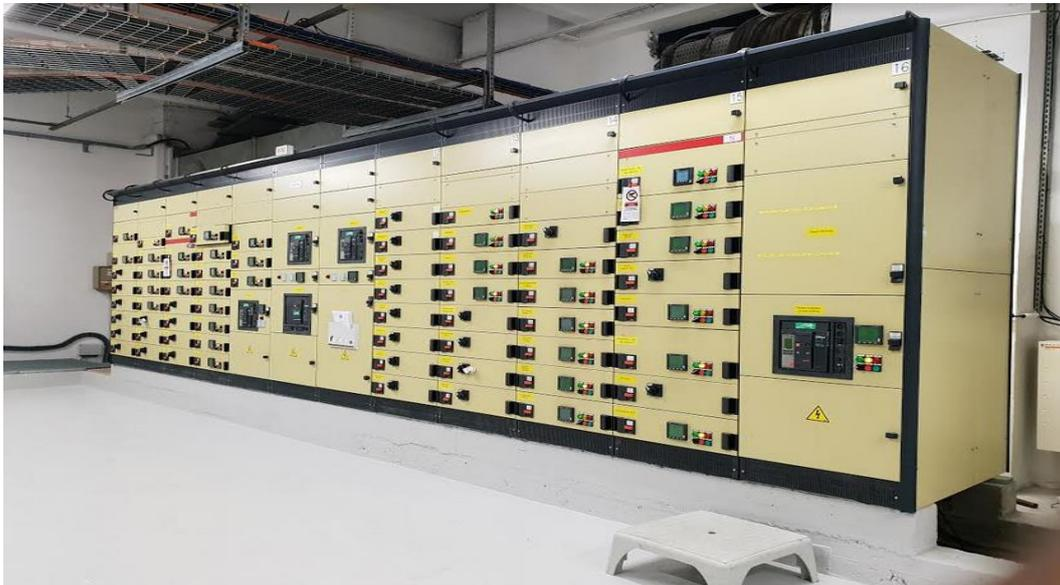
Figure III.3 : tableau général basse tension (TGBT).
