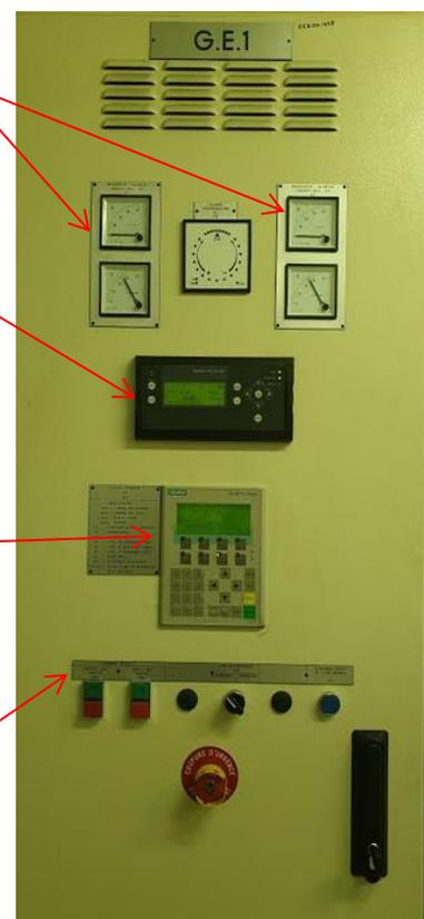
Figure II.5 : armoire de commande d'un GE.
