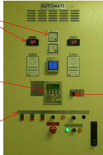
Figure II.6 : armoire Automate de contrôle.
