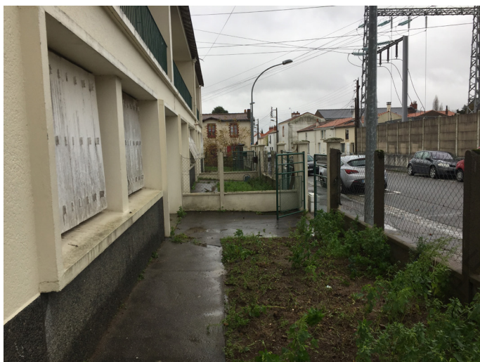
Vue extérieure de la maison côté rue
