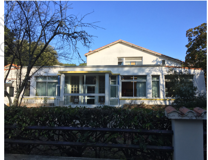
Vue extérieure du foyer
