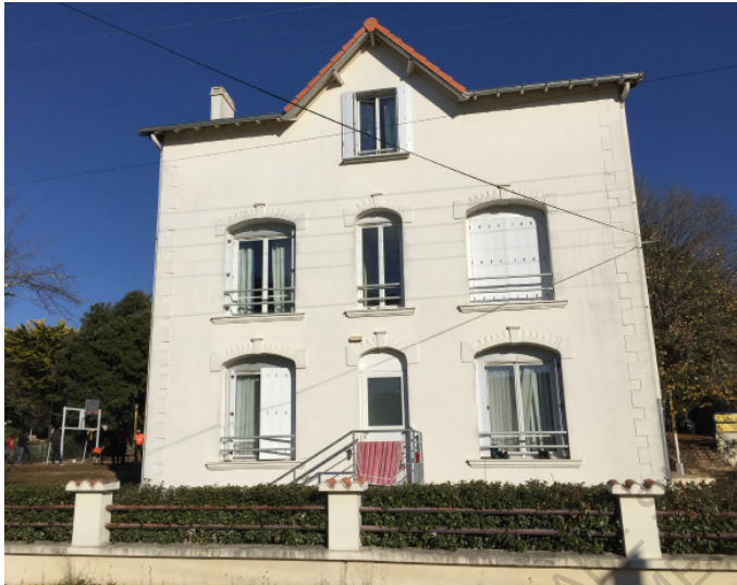
Vue extérieure du foyer
