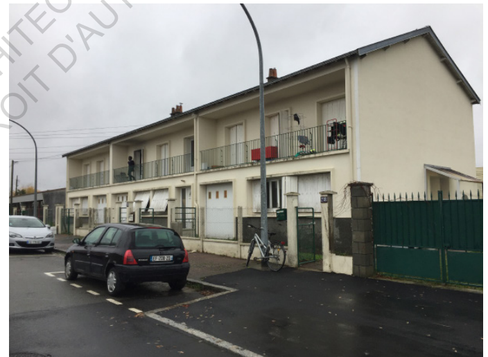
Vue extérieure de la maison côté rue
