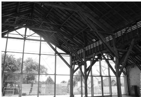
Halle au Pellerin, Michel Rouleau, architecte
