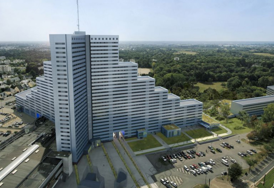
SILLON DE BRETAGNE, 2014
