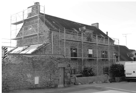
Restauration d'une maison ancienne
