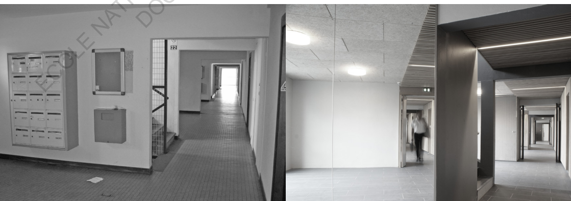
COULOIR AVANT LES TRAVAUX
