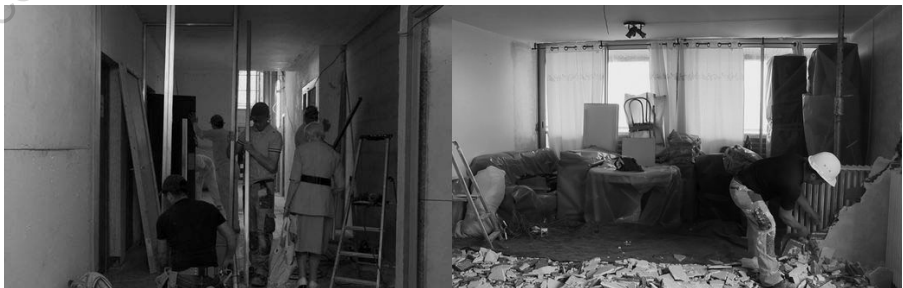
CHANTIER EN SITE OCCUPÉ, EXTRAIT GUILLAUME MEIGNEUX, HABITATIONS, LÉGÈREMENT MODIFIÉES, 2013
