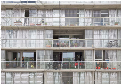
BALCONS HABITÉS, TOUR-BOIS-LE-PRÊTRE, 2011
