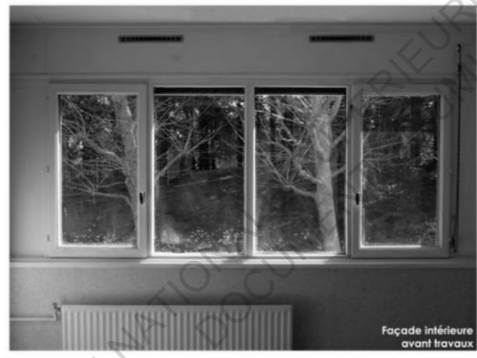
FAÇADE INTÉRIEURE AVANT TRAVAUX
