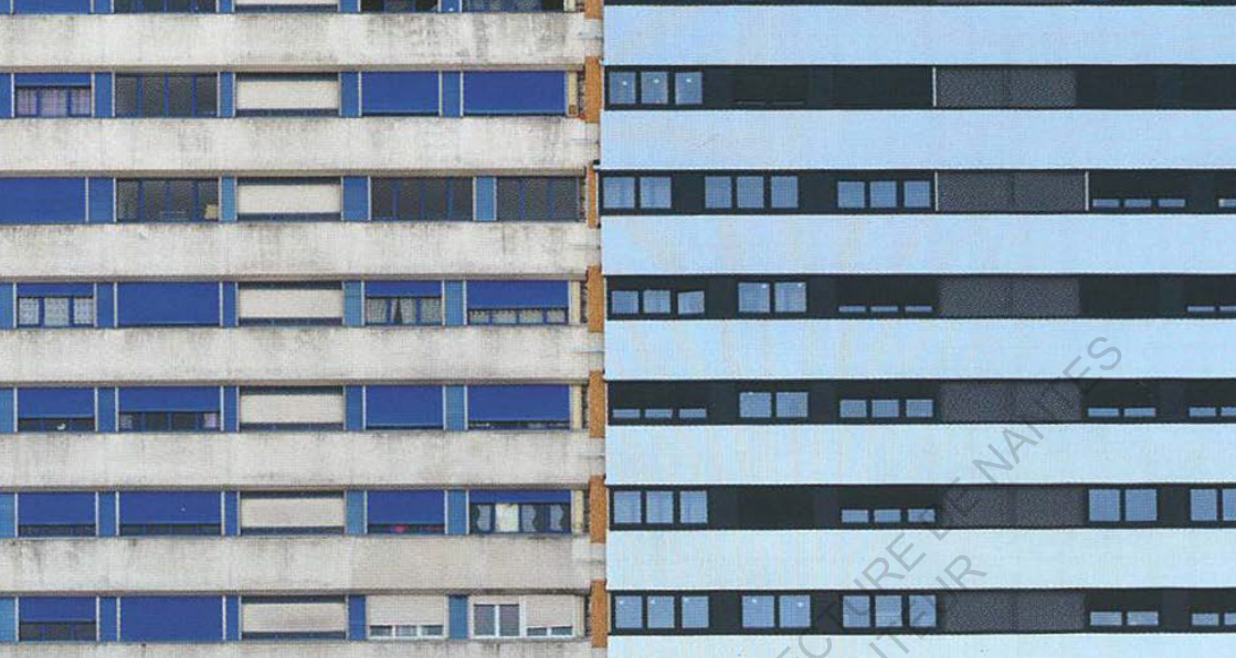
22 MAI 2012 : À GAUCHE, L'ANCIENNE FAÇADE ET À DROITE, LA FAÇADE TRANSFORMÉE. ©WILLY BERRÉ PHOTOGRAPHE
