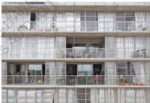
BALCONS HABITÉS, TOUR-BOIS-LE-PRÊTRE, 2011
