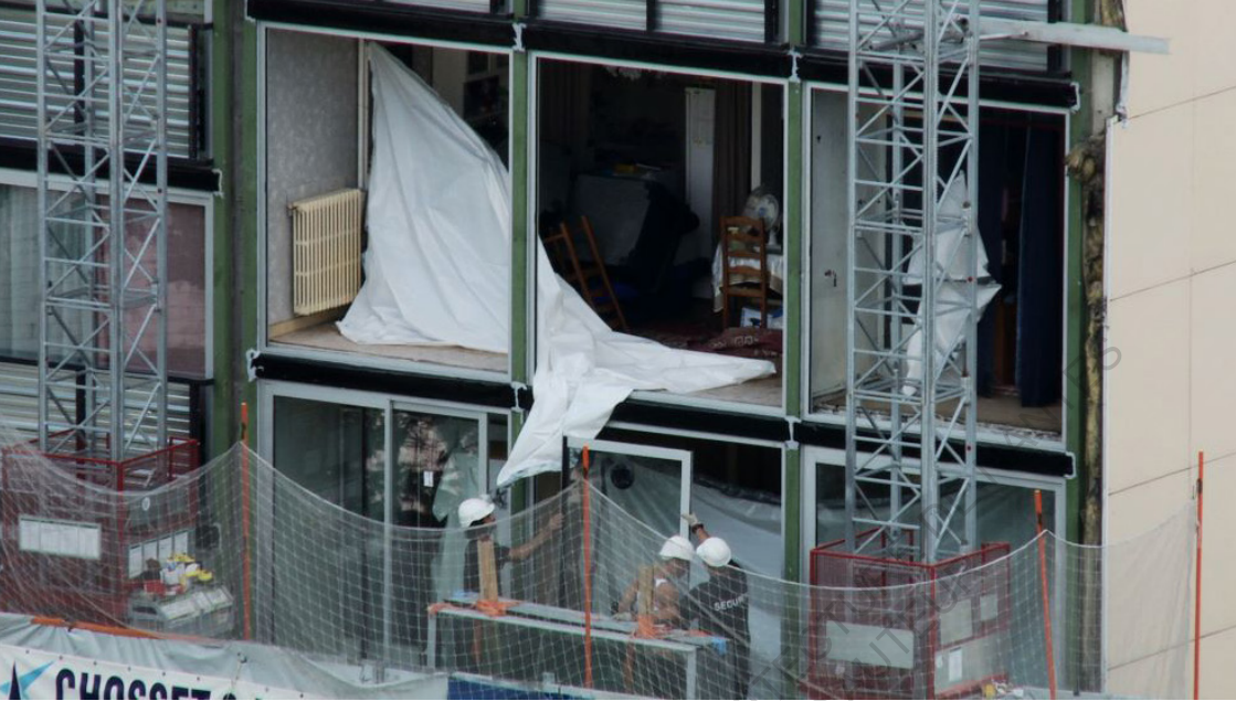
CHANTIER EN SITE OCCUPÉ, EXTRAIT GUILLAUME MEIGNEUX, HABITATIONS, LÉGÈREMENT MODIFIÉES, 2013
