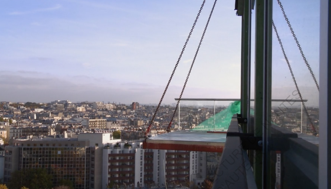
POSE DES JARDINS D'HIVER, VUE DEPUIS UN LOGEMENT, EXTRAIT GUILLAUME MEIGNEUX, HABITATIONS, LÉGÈREMENT MODIFIÉES, 2013
