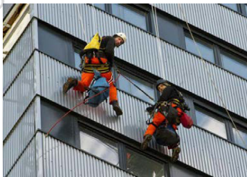
PHOTO DE LA MISE EN PLACE DES NOUVELLES FENÊTRES
