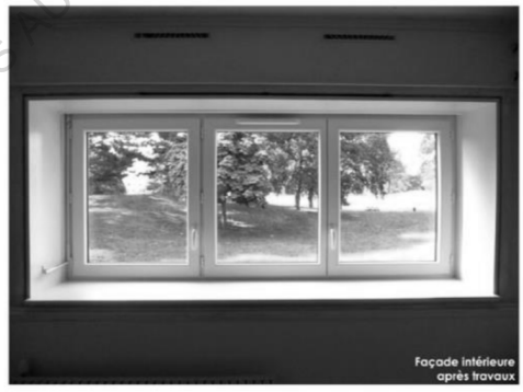
FAÇADE INTÉRIEURE APRÈS TRAVAUX
