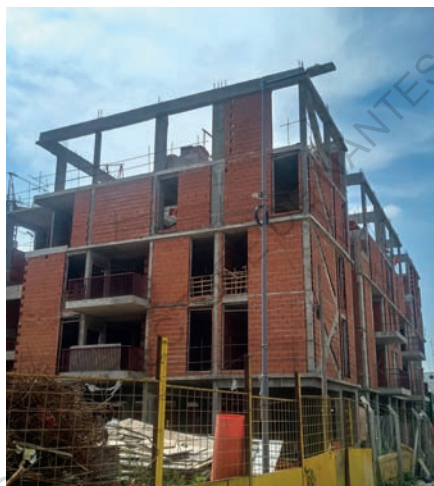
Nouveaux édifices en construction pour la relocalisation des habitants de la villa 20.
