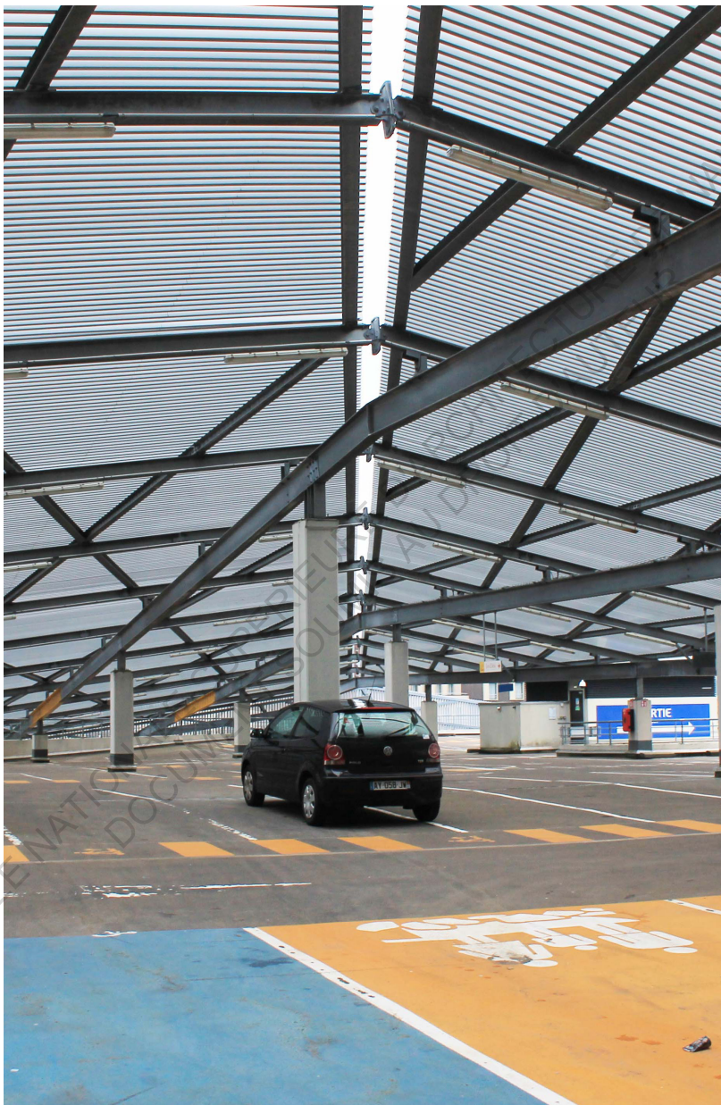
Toiture et structure
