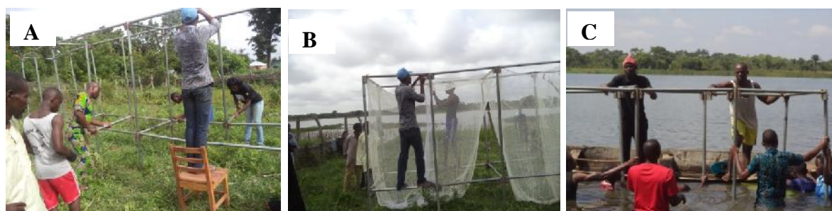
Figure 7 : Installation des infrastructures dans les retenues d'eau (A: montage des cadres à Batran ; B : montage des poches de filets à Batran ; C: installation des cadres dans l'eau à Songhaï) (Travaux de recherche, 2016)
