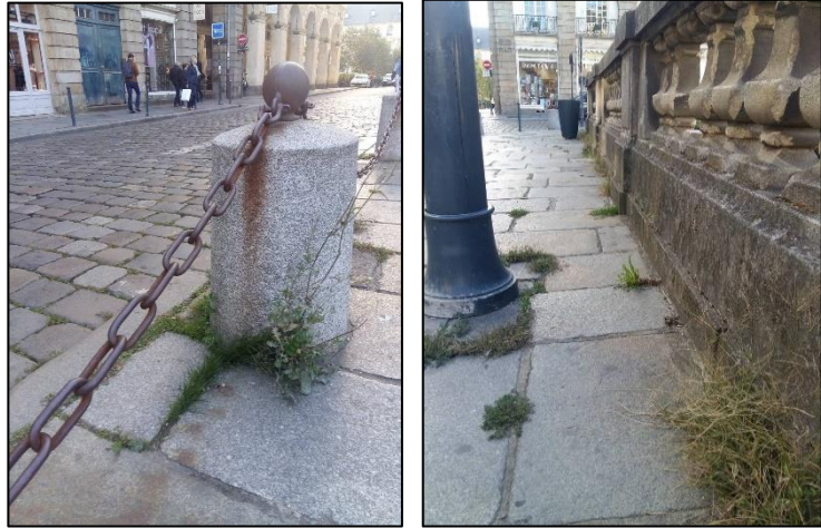
Figure 50 : Présence de végétations spontanées aux abords du Parlement de Bretagne de Rennes [photo personnelle] juin 2018
