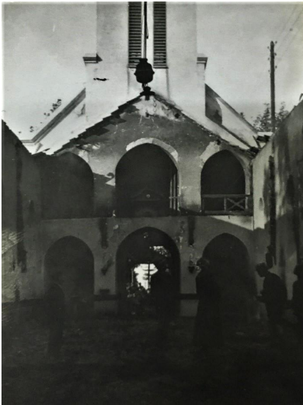
L'église de Fouka après l'incendie.
