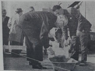
CHIRY-OURS CAMPS. - Pose de la première pierre du bureau de postes en septembre 1972
