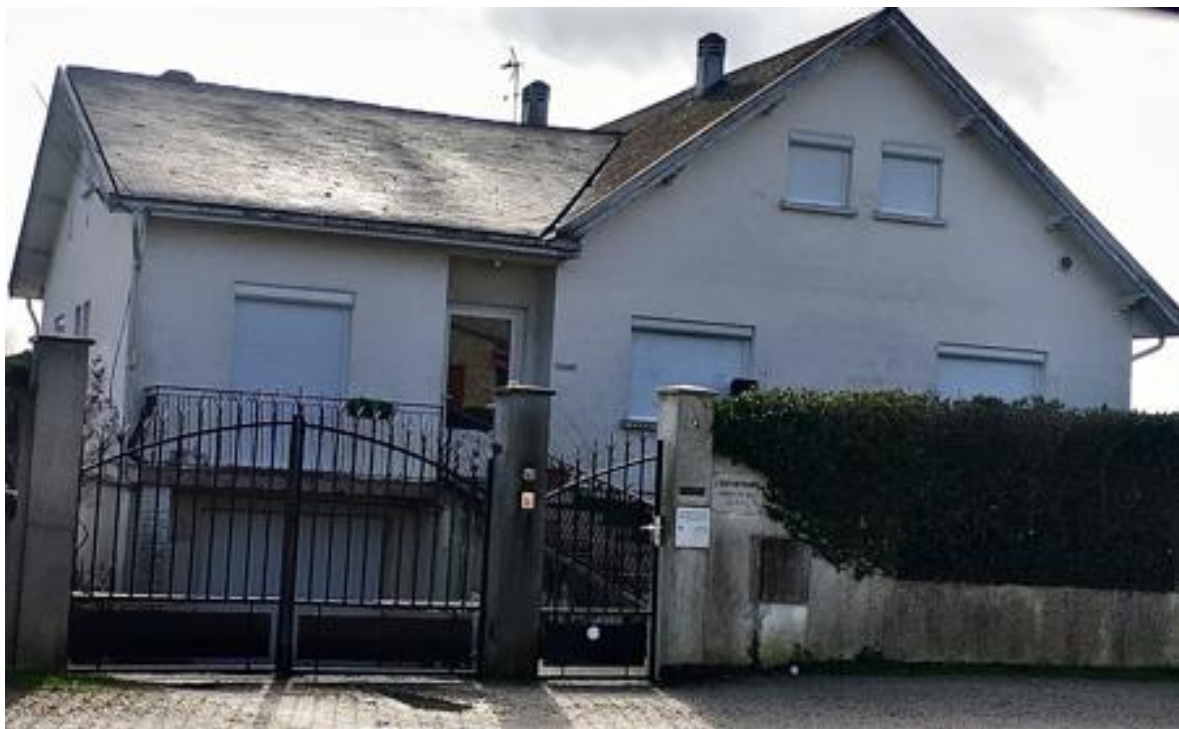
Figure n° 3 : Photographie du CMP Entretemps, 9 avenue du derby, 33320 Eysines, prise le 26/01/20
