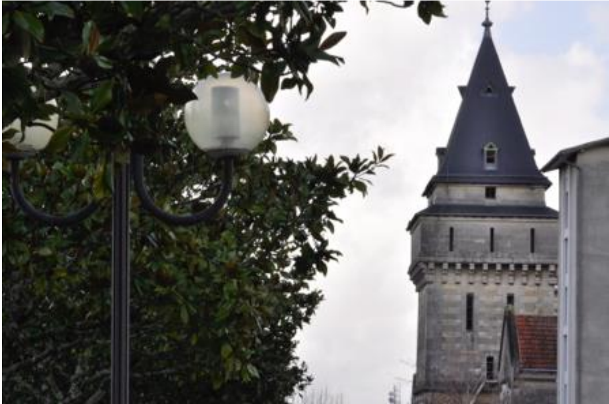
Figure n°1 : Photographie du Centre Hospitalier de Charles Perrens, photo prise le 26/01/2020
