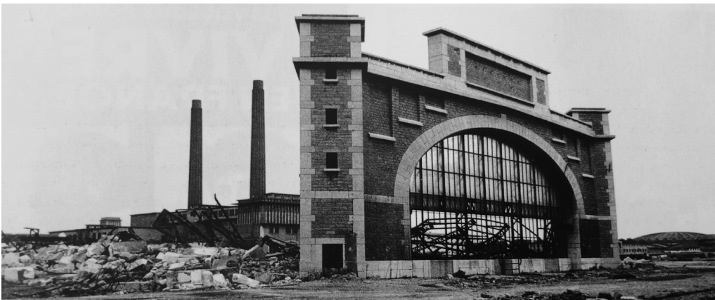
Démolition des abattoirs de Gerland, 1978 © Archives municipales de Lyon, Fonds Tabey
