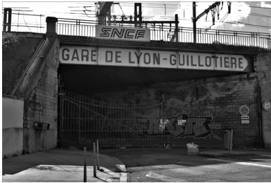
Ancienne voie d'accès à la gare de marchandises Lyon-Guillotière, 2020 © Axelle MICHEL
