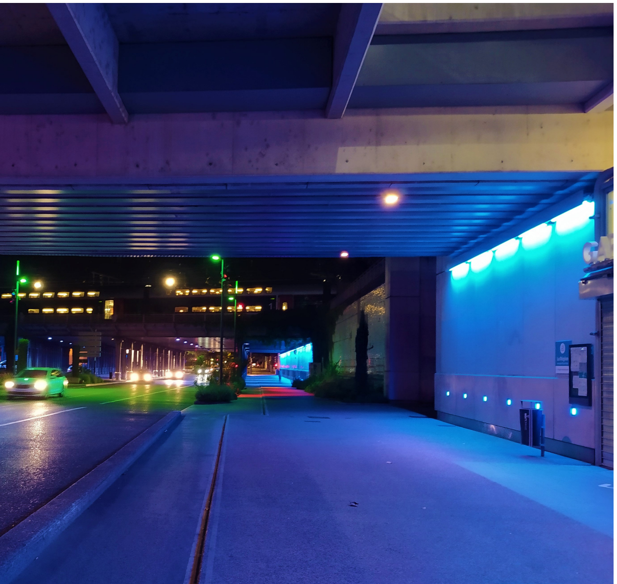
Mise en lumière de la structure de nuit © Axelle MICHEL
