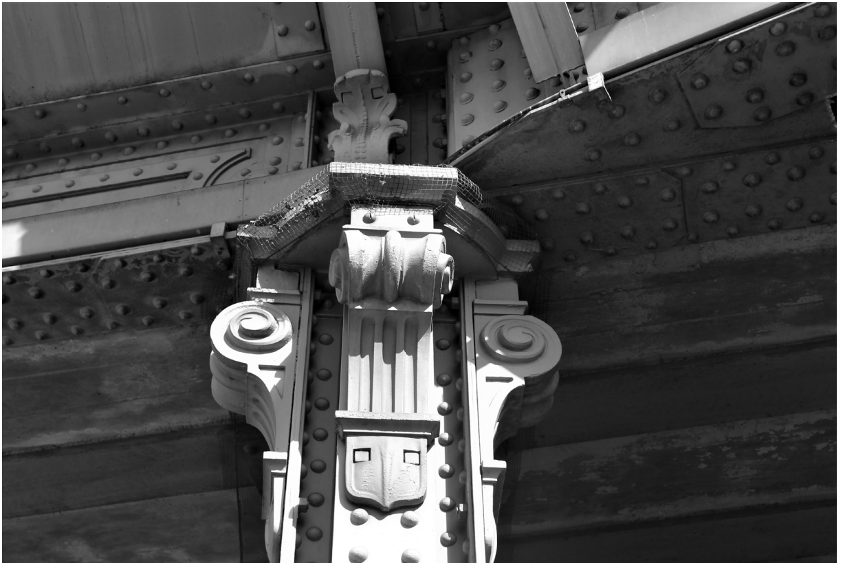
Détails structure © Axelle MICHEL
