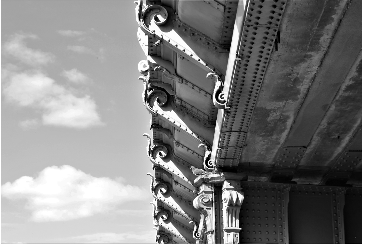
Détails structure © Axelle MICHEL
