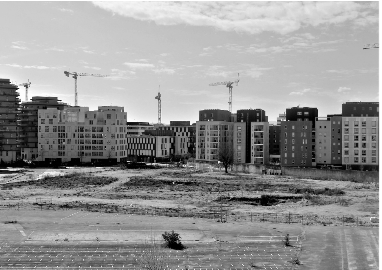
Vue sur la friche Nexans et la ZAC Les Girondins en cours de livraison © Axelle MICHEL
