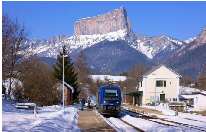
Figure 13 : Gare de Clelles-Mens sur la ligne du Trièves. Ciché : J. Diebold
