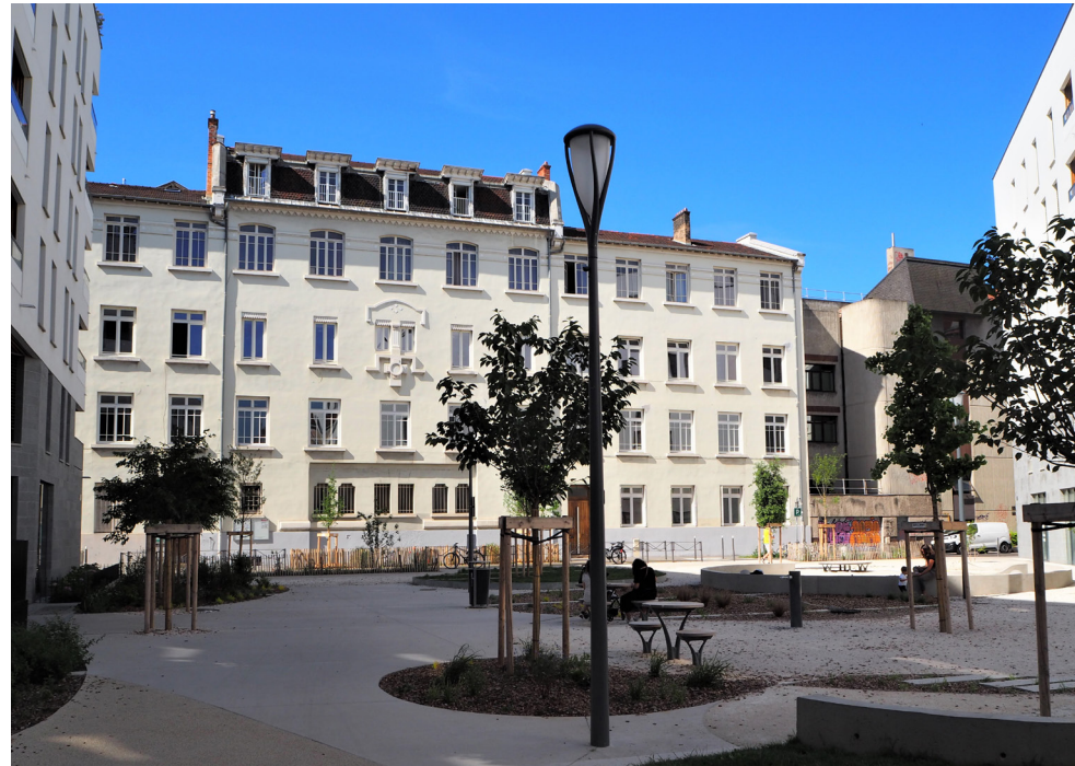
Placette aménagée pour les piétons entre la rue Professeur Grignard et la rue d'Anvers - 27/05 - 10h
