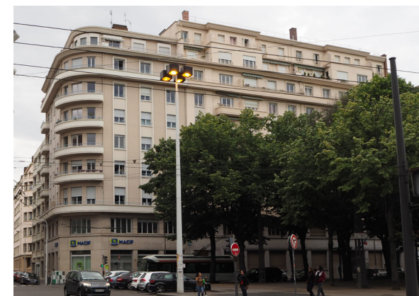
Bâtiment construit en 1952 - 5 Place Jean Macé - 08/06 - 18h [Cette photographie a été prise suite à la deuxième phase de déconfinement.]
