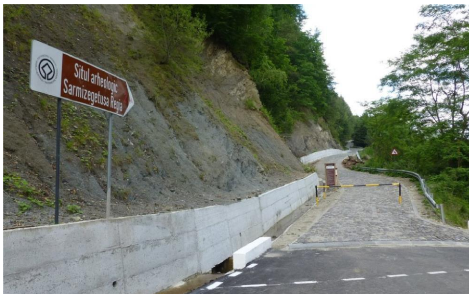
ILLUSTRATION 17 : UNE UNIQUE VOIE D'ACCÈS AU SITE, LE RÉSULTAT D'UN AMÉNAGEMENT RÉCENT
