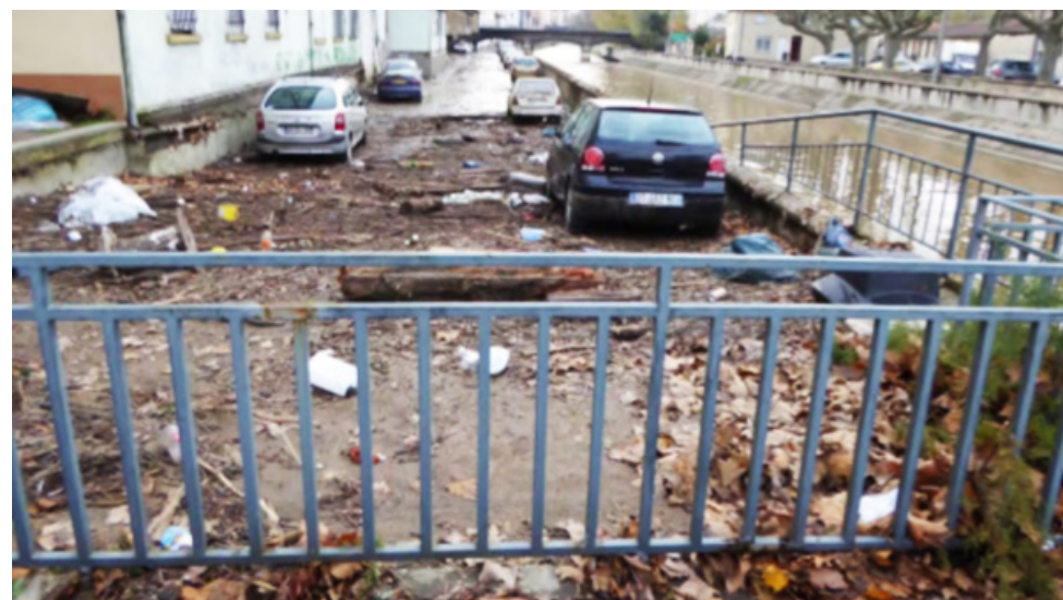
Photo 12 : Dégâts consécutifs à la crue de Novembre 2016 Source : Dossier d'étude d'impact « Création ZAC », 2017, Ville d'Oullins. Page 156
