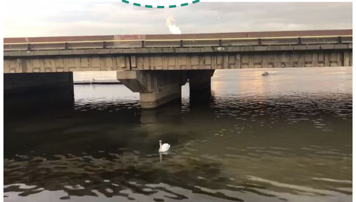
Photo 19 : Secteur 4 Traits visibles de pollution dans le canal de l'Yzeron en confluence avec le Rhône. La photo a été prise le 8 Février 2020.
