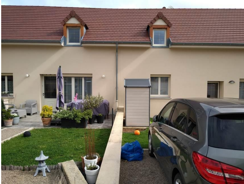
Figure 1 Maisons mitoyennes présentant une toiture commune Photographie issue d'un chantier de TT Géomètres Experts - Quetigny
