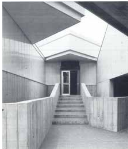
Figure O4 Entrée des bureaux Image P.E.A.
