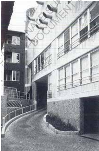
Figure B9 Façade sur cour Image P.E.A.
