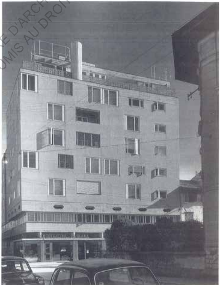
Figure D6 Façade sur rue Image P.E.A.
