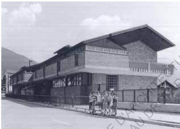
Figure K6 Façade sur la rue Image M.S.S.
