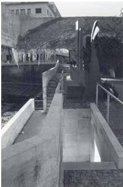
Figure G7 Les escaliers et la plateforme basse Image P.E.A.
