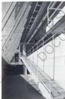
Figure N12 Renforts ajoutés après le tremblement de terre de 1976 Image M.S.S.
