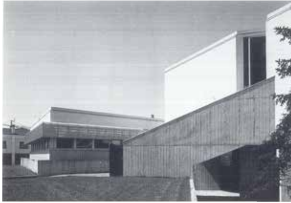
Figure 05 Vue sur l'escalier d'accès à la salle du conseil Image P.E.A.
