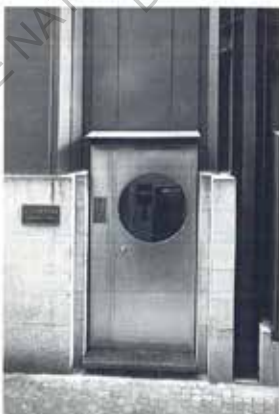
Figure C9 L'entrée des appartements sur la rue latérale Image P.E.A.
