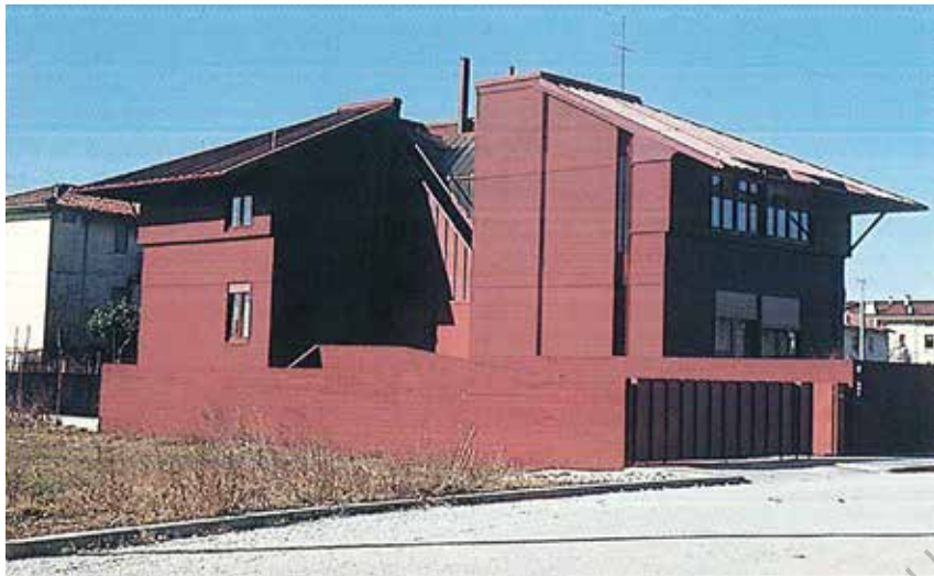
Figure E6 Façade sur rue Image P.E.A.
