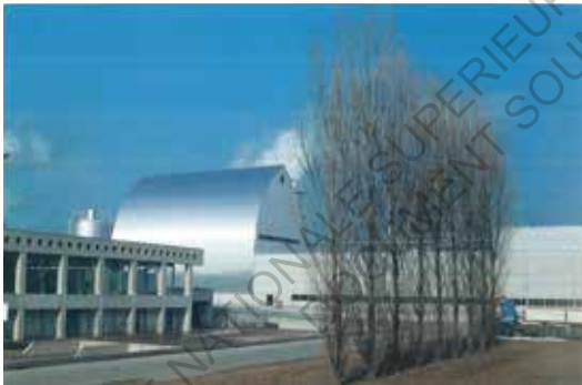
Figure N6 Vue extérieure Image P.E.A.
