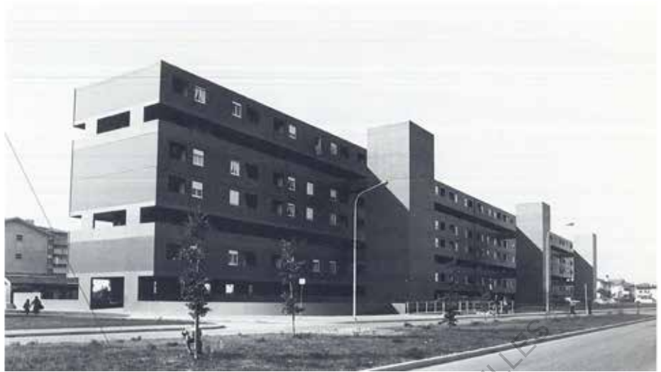
Figure H3 Façade sur rue Image P.E.A.
