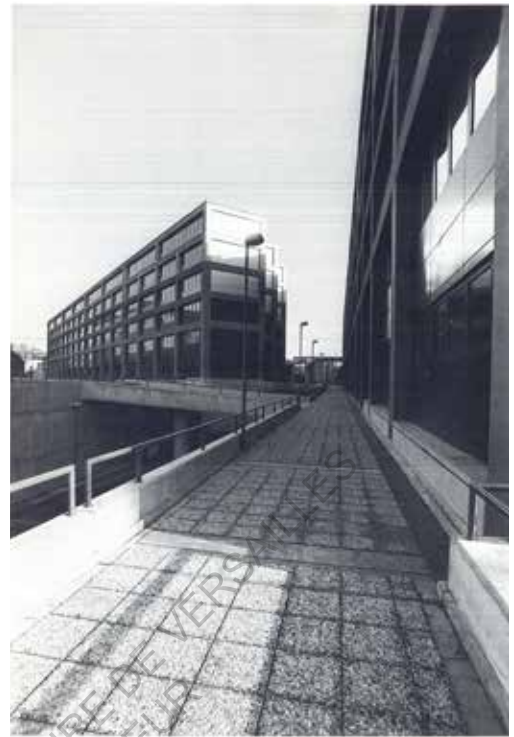
Figure R6 Vue en arrivant de la gare Image P.E.A.
