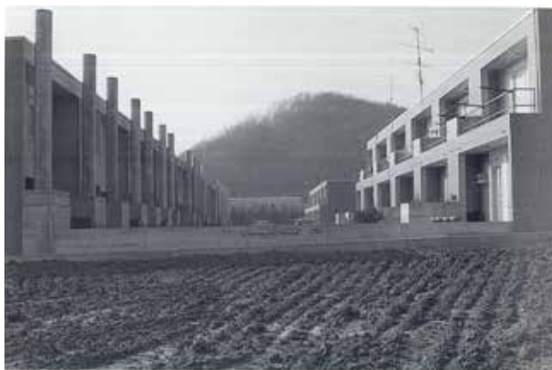
Figure I-3 Vue sur les maisons Image P.E.A.
