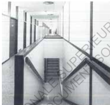
Figure Q14 Corridor et escalier du 2 e étage Image P.E.A.
