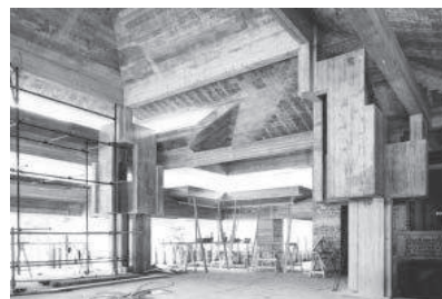
Vue de la salle principale en chantier (Corbellini et Rocca)
