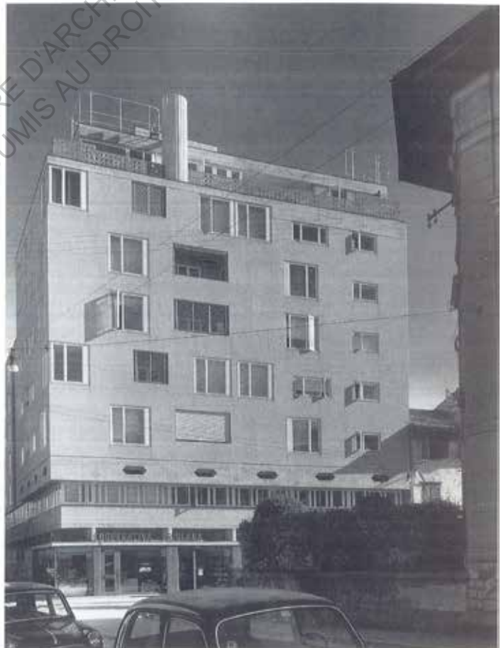
Figure D6 Façade sur rue Image P.E.A.
