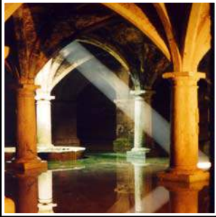
Voûtes en blocs de pierre
