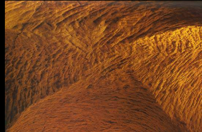
Voûte croisée creusée dans une galerie d'ocre à Roussillon. © OKHRA 2004 [236]
