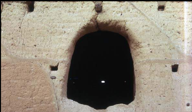
Il n'est pas rare d'observer des ouvertures en forme d'arc dans des murs en pisé. © CRATerre
