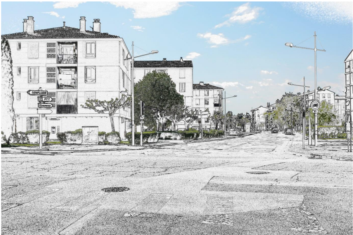
Figure 108 : Avenue du Président Coty, intersection avec l'avenue Stalingrad vers l'ouest (tracé ligne 2)
