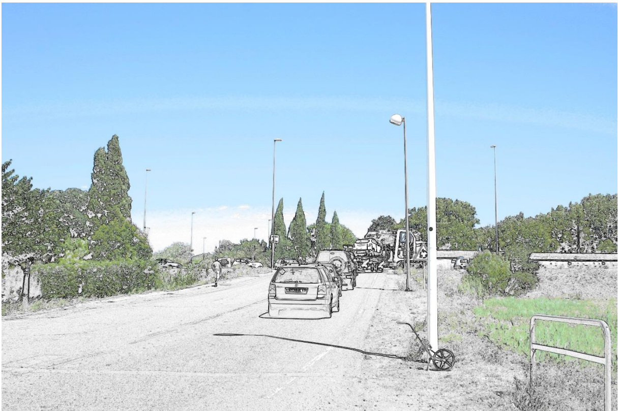
Figure 106 : Avenue des Arches, à proximité du rond-point de Pont de Crau/de la Première Armée Française Rhin et Danube (tracé ligne 1)
