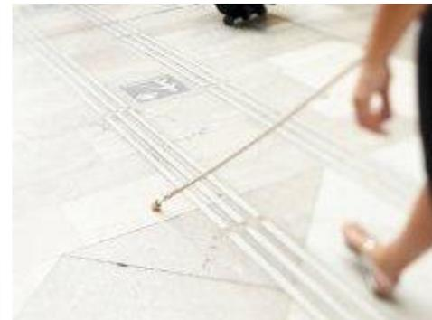
**Figure 59 Borne podotactile de guidage (<http://www.accessibilite.sncf.com/la-demarche-d-accessibilite/equipements/article/la-bande-podotactile>)**
