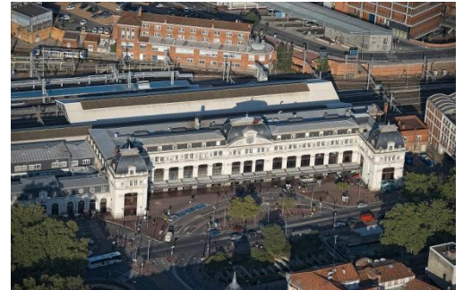
Figure 26 Photo aérienne de la gare Toulouse Matabiau en 2010 © région midipyrenées.fr
