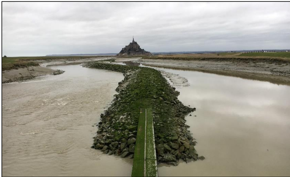
Photographie 3 - Seuil séparant le Couesnon en deux, en aval du barrage.
