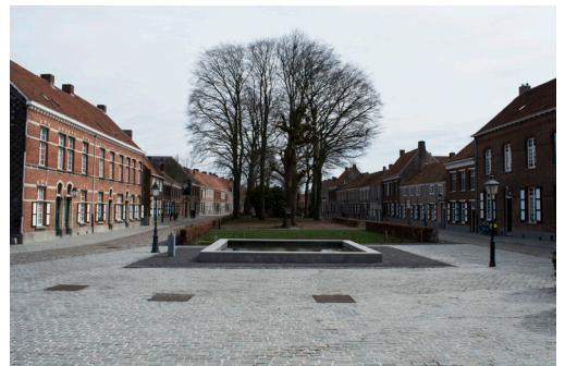
Depuis le parvis de l'église - vue sur préau
