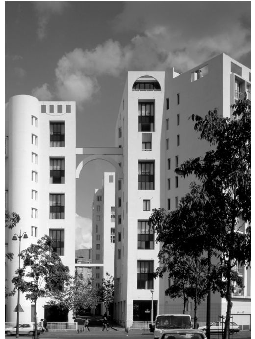
Photo depuis la rue Baudricourt
