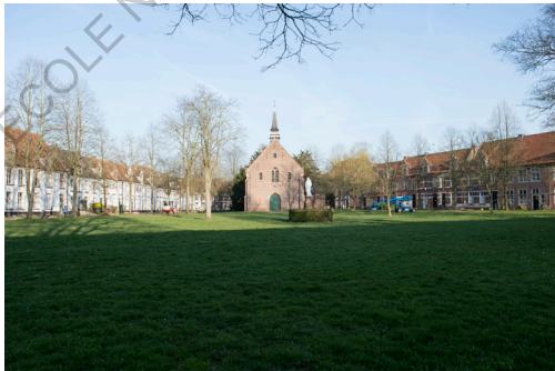
Face à l'église - vue sur préau
