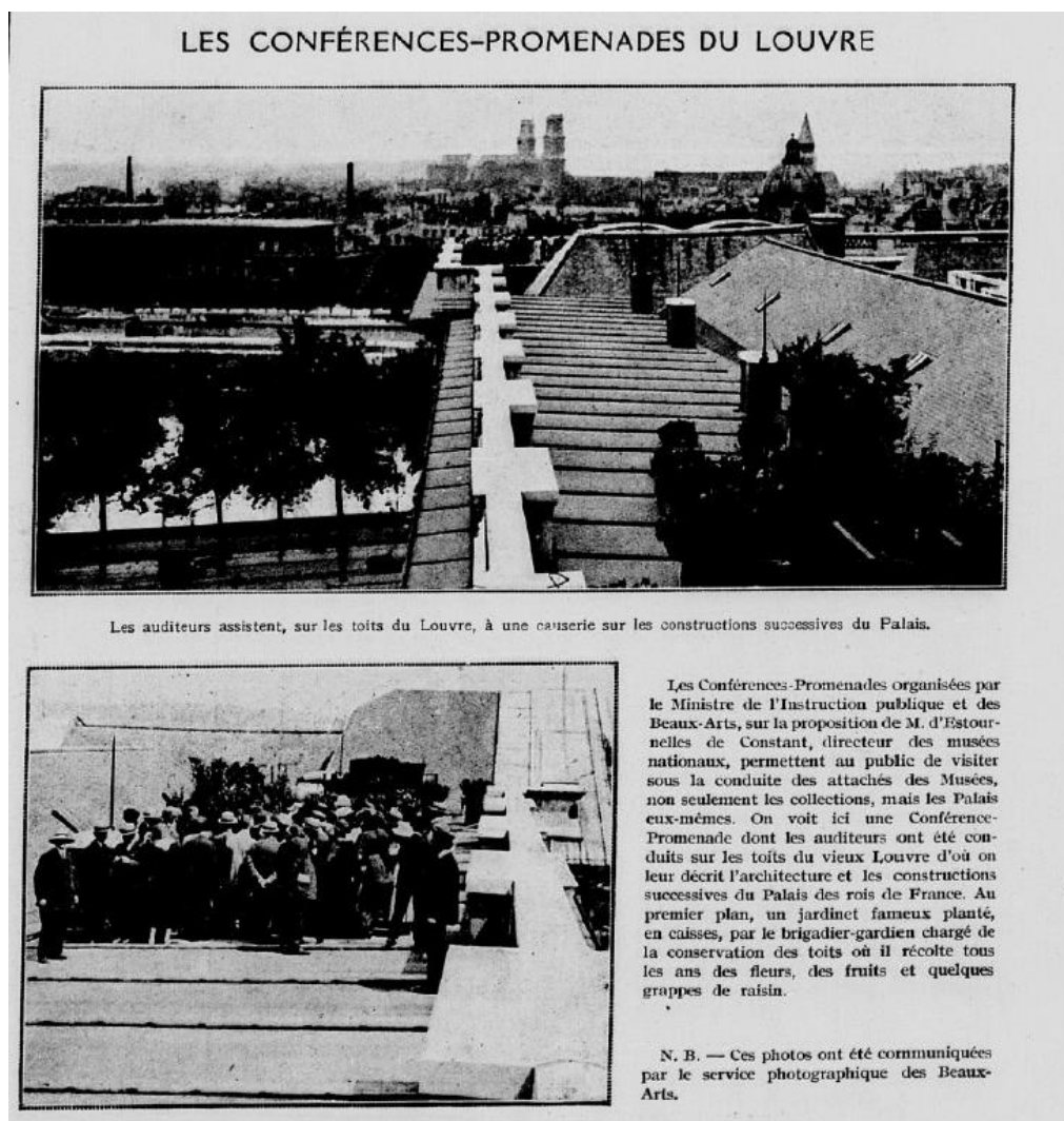
FIGURE 4 : Conférence-promenade « Visite des toits du Vieux-Louvre » (1920)
