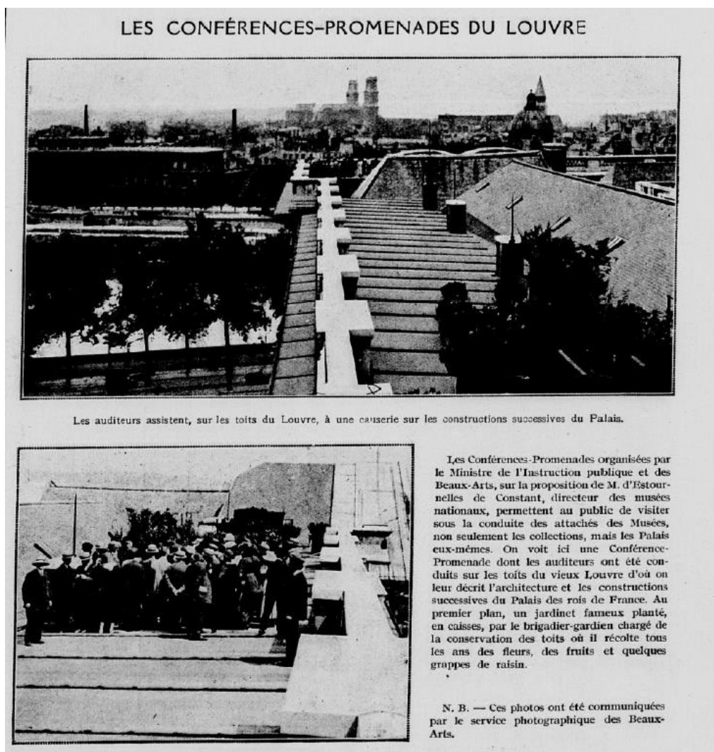
FIGURE 4 : Conférence-promenade « Visite des toits du Vieux-Louvre » (1920)
