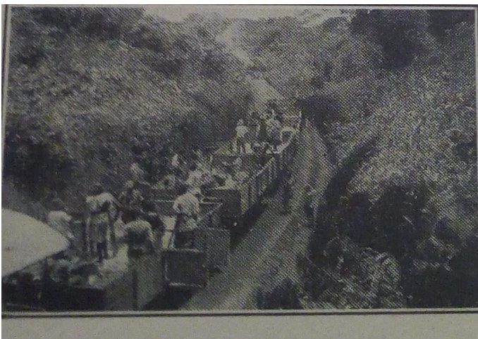
Illustration 17: Une voie ferrée dans l'Afrique équatoriale.
