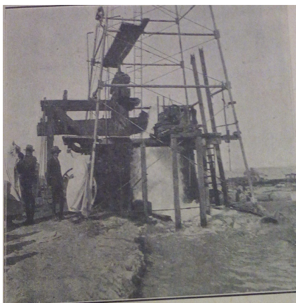
Illustration 19: Le percement d'un puits artésien.
