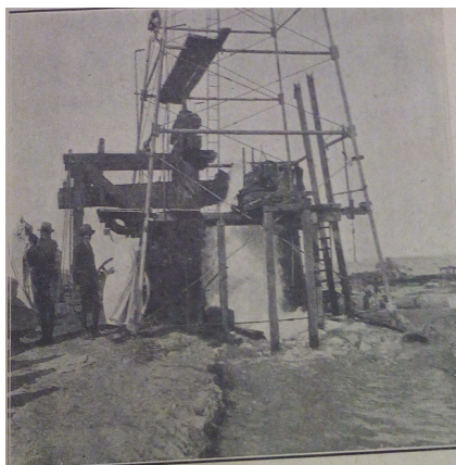
Illustration 19: Le percement d'un puits artésien.
