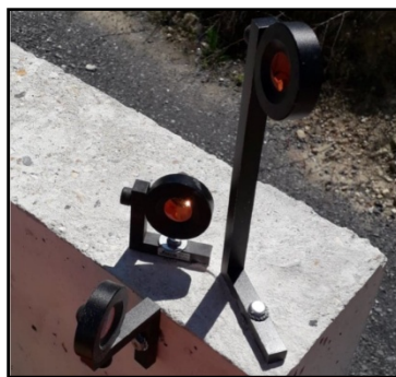
Figure n°9 : Photographie de l'installation d'un triplet de prismes.
