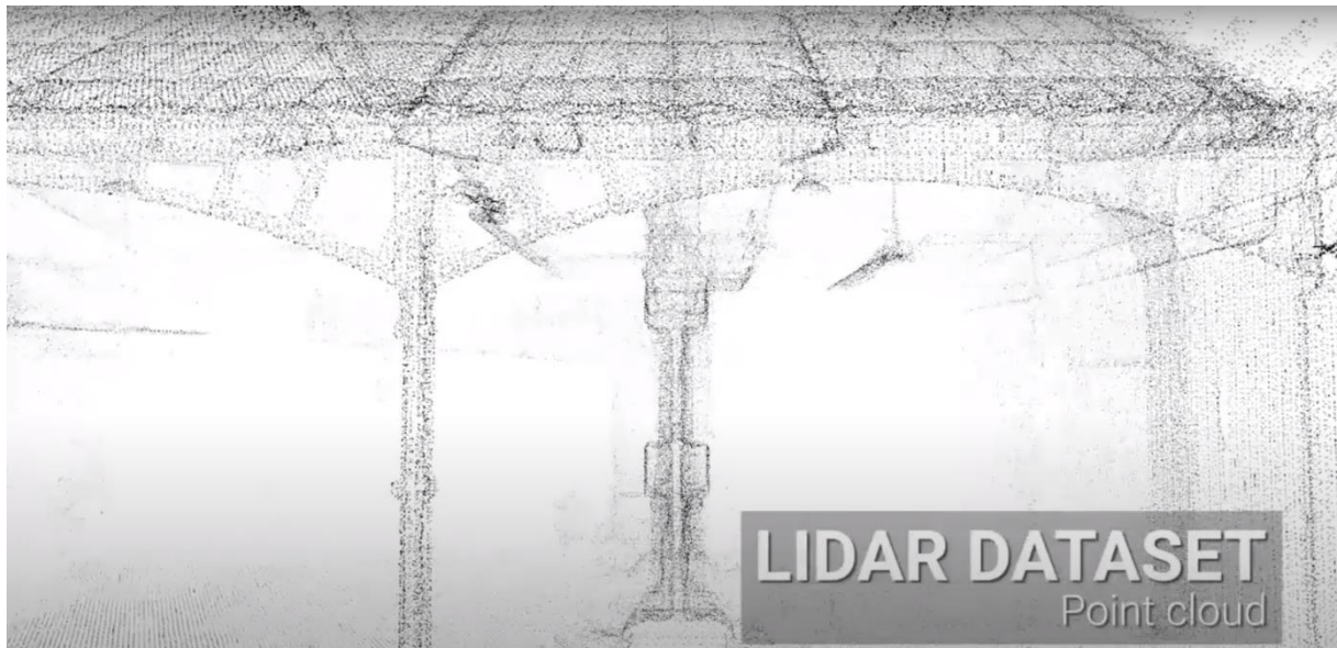
Figure 43 : Nuage de points LIDAR du marteau pilon des forges de Pontaniou Source : Virtualys / vidéo : https://www.youtube.com/watch?v=fnuPnRaYxeQ
