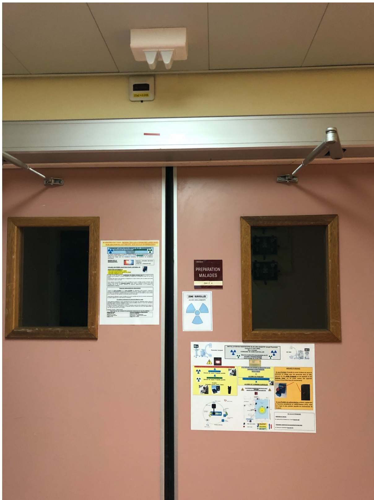
Figure 32 : information de radioprotection sur une porte de salle opératoire
